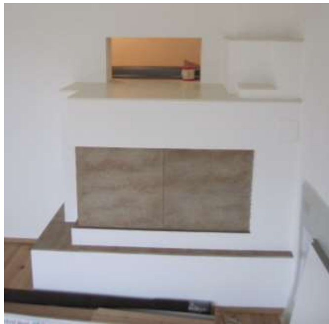
Abbildung 99: Linkes Bild: Kombispeicher (links), Elektroheizstab (Mitte); Rechtes Bild: Hauptteil des Stückholz-Kachelofens im Wohnzimmer (Quelle: AIT)
