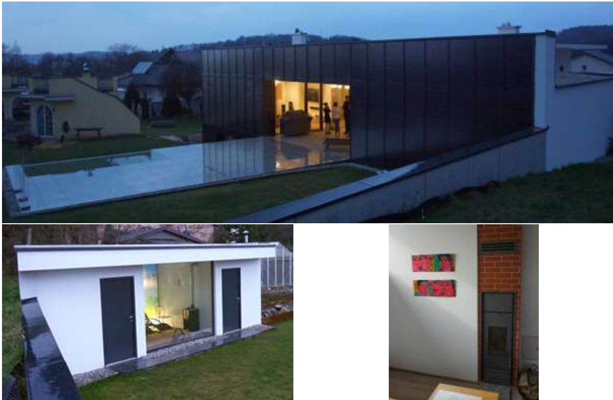
Abbildung 48: Gebäude-Südansicht (oben), Gartensauna (unten links) sowie wassergeführter Wohnraumofen (unten rechts) des Solarhauses Maier (Quelle: AEE INTEC)
