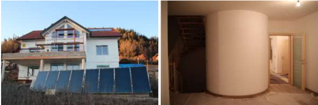
Abbildung 135: Südansicht des nahezu fertigen Gebäudes (links); Ansicht des integrierten Pufferspeichers (rechts, Quelle: AIT)
