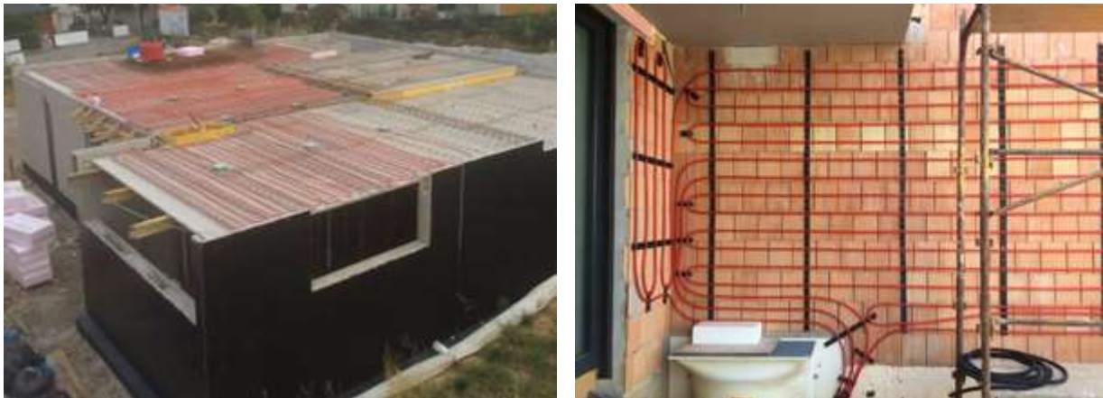
Abbildung 49: Verlegung der Bauteilaktivierung von Zwischendecke (links) und Nordwand (außenliegend, rechts) (Quelle: Bauherr)
