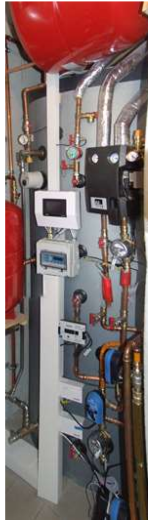
Abbildung 27: Solaranlage mit Einstrahlungssensor (oben links), Lüftungsanlage (unten links) und Pufferspeicher (rechts) (Bildquelle: AEE INTEC)
