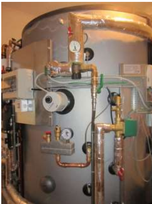
Abbildung 99: Linkes Bild: Kombispeicher (links), Elektroheizstab (Mitte); Rechtes Bild: Hauptteil des Stückholz-Kachelofens im Wohnzimmer (Quelle: AIT)
