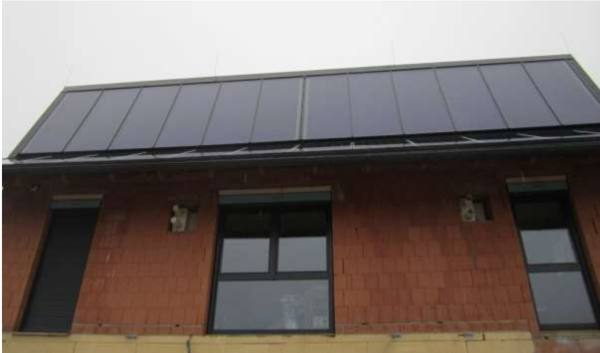
Abbildung 98: Süd-Südwest-Ansicht des Gebäudes mit Solarthermie-Kollektoren (oben) und PV-Modulen (unten), (Quelle: AIT)
