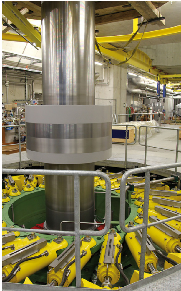
Turbinen mit hohem Wirkungsgrad wandeln das gestaute Wasser im Pumpspeicherkraftwerk wieder in Strom um. (Foto: Verbund Hydro Power)
