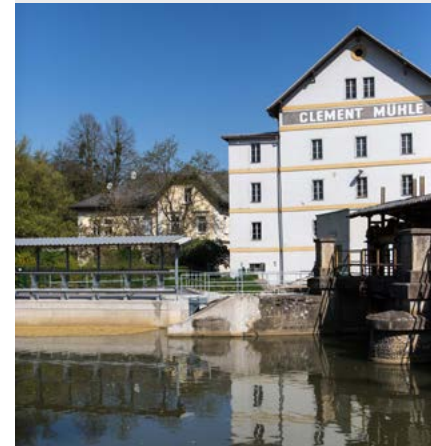
◀ PV-Anlage Freizeitzentrum Feldbach ▲ Kleinwasserkraftwerk Clement Mühle beide Fotos: LEA GmbH
