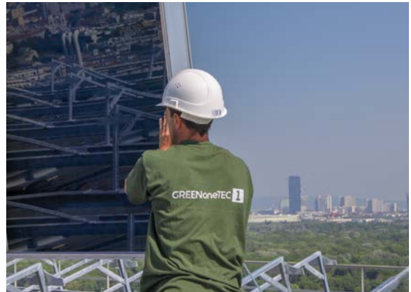
Start einer nachhaltigen Wärmeversorgung, Quelle: GREENoneTEC
