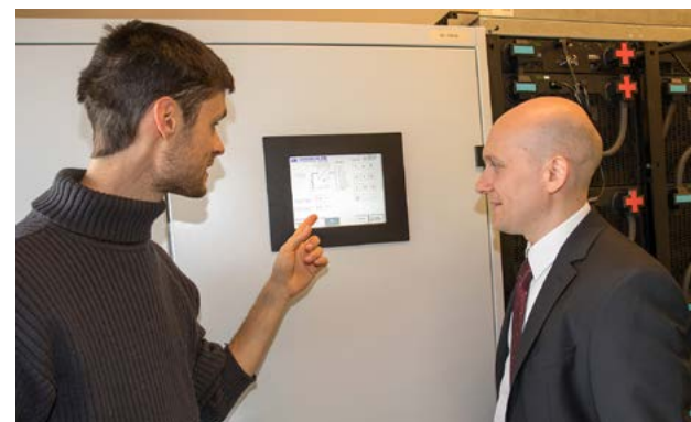
Speicher Heimschuh, alle Fotos oben: Energie Steiermark/Symbol
