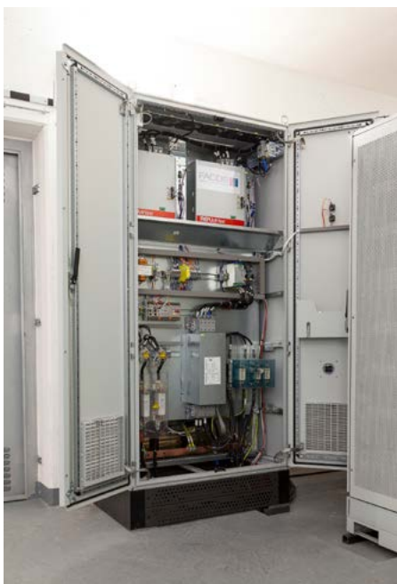
FACDS Umrichter, Foto: Wiener Netze GmbH
