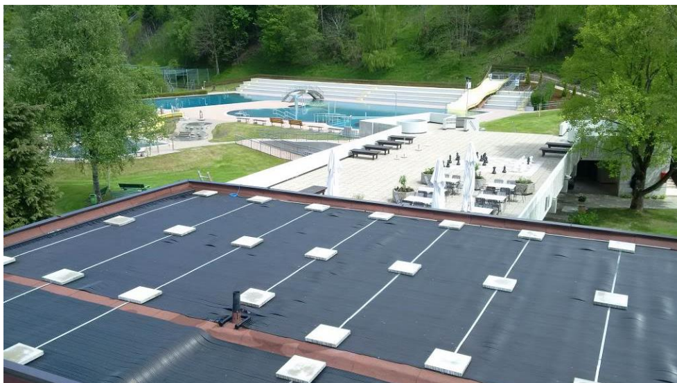
Abbildung 8: Solar Absorber Anlage Freibad Schwaz (Quelle: AST Eis- und Solartechnik GmbH)
