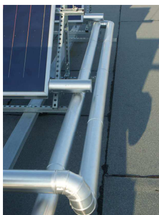
Abbildung 26: Links ist ein positives Beispiel und rechts ein negatives Beispiel bezüglich Rohrleitungsdämmung und Witterungsschutz im Freibereich dargestellt
