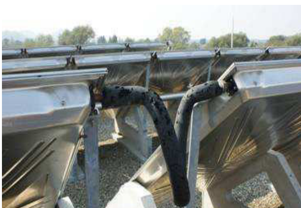
Abbildung 26: Links ist ein positives Beispiel und rechts ein negatives Beispiel bezüglich Rohrleitungsdämmung und Witterungsschutz im Freibereich dargestellt
