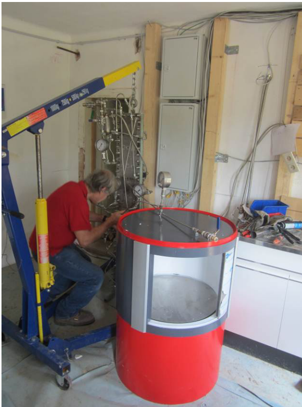
Abbildung 97: Aufstellung des Kühltank-Prototyps am Standort in Böheimkirchen
