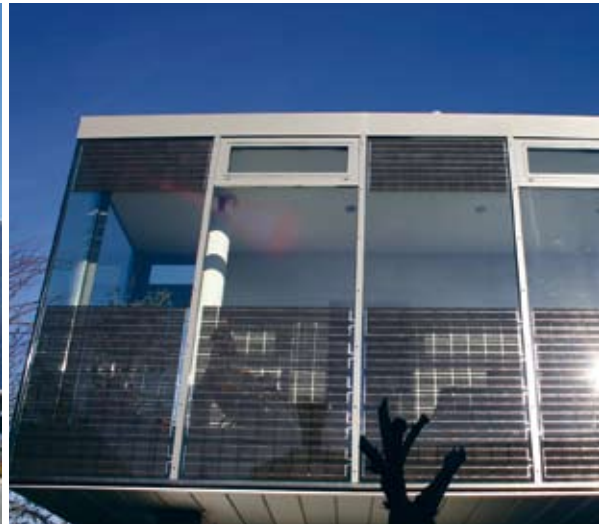
Sichtschutz PV als Brüstungselement (Ertex-Solar)
