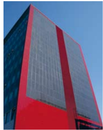
Glasfassade mit integrierter PV, Wirtschaftskammer Österreich in Wien
