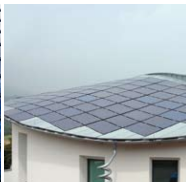
Integration in Schrägdach (Energetica Energietechnik GmbH)
