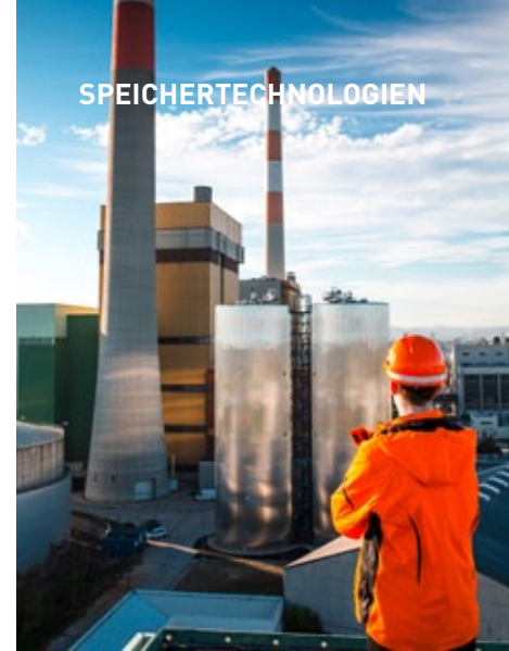
Hochdruck-Wärmespeicher am Gelände des Kraftwerks Simmering Foto: Wien Energie/Ian Ehm
