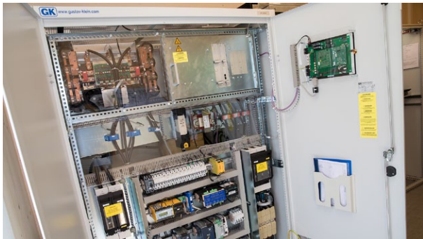
Speicherblock und Steuerung Heimschuh, Fotos: Energie Steiermark/Symbol
