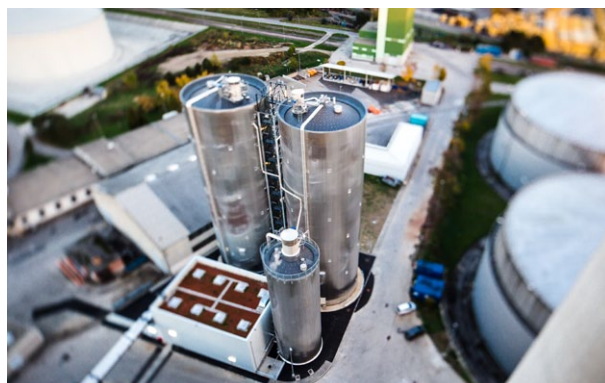
Hochdruck-Wärmespeicher am Gelände des Kraftwerks Simmering, Foto: Wien Energie/Ian Ehm
