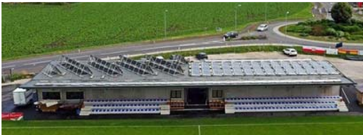
Abbildung 19: Vereinsgebäude mit Solarthermie- und Photovoltaik-Kollektoren auf dem Dach. Quelle: http://www.union-ansfelden.at
