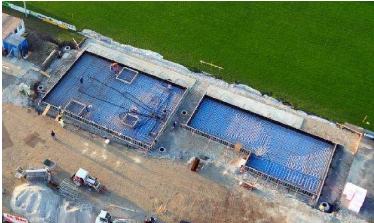
Abbildung 20: Ansicht der Heizrohre zur Betonkernaktivierung während der Errichtung. Quelle: http://www.kuster.co.at
