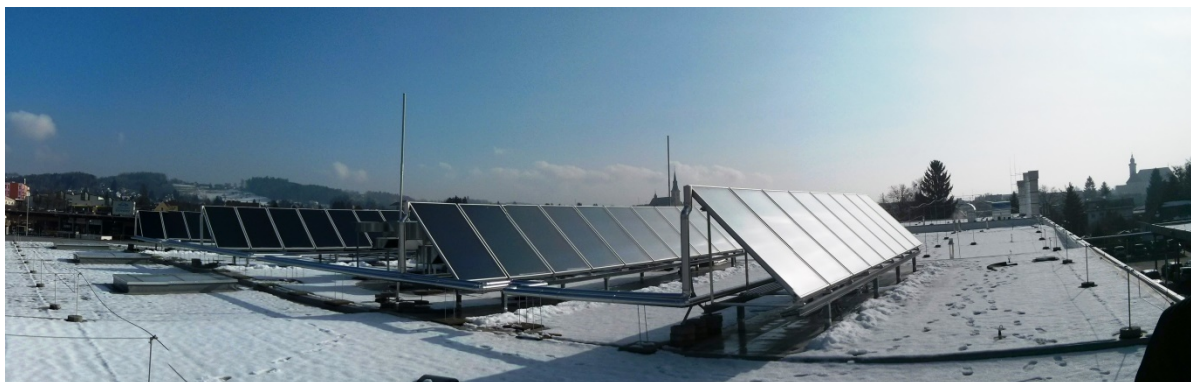
Abbildung 6: Ansicht der am Dach des Autohauses aufgeständerten Kollektoren (Bildquelle: AEE ITNEC)
