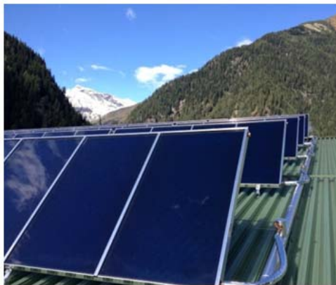
Abbildung 7: Detailaufnahme der Kollektorreihen (links, Bildquelle: Biowärme Mallnitz) sowie des 80 m 3 Pufferspeichers im Zuge des Errichtung (rechts, Bildquelle: Biowärme Mallnitz)
