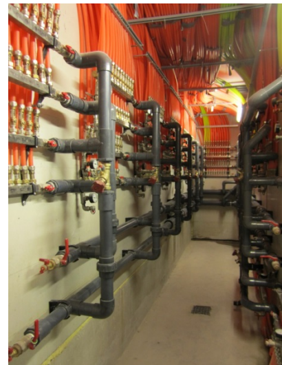
Abbildung 56: Ansicht der Heizzentrale bzw. der Wärmepumpen (linke Abbildung) und Darstellung der Verteiler und der Verrohrung der Rohrregister für den Erdspeicher (rechte Abbildung). Quelle: AIT
