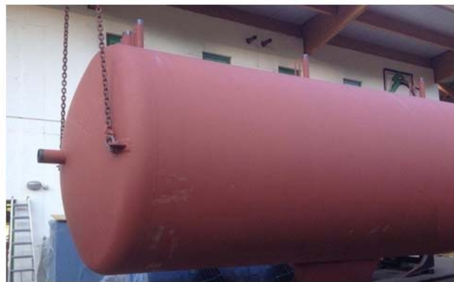
Abbildung 7: Detailaufnahme der Kollektorreihen (links, Bildquelle: Biowärme Mallnitz) sowie des 80 m 3 Pufferspeichers im Zuge des Errichtung (rechts, Bildquelle: Biowärme Mallnitz)
