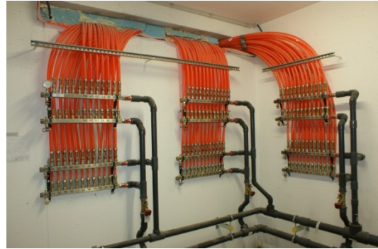
Abbildung 30: Wärmepumpen (linkes Bild); Verteiler und Verrohrung der Rohrregister für den Erdspeicher (rechtes Bild) (Bildquelle: AEE INTEC).
