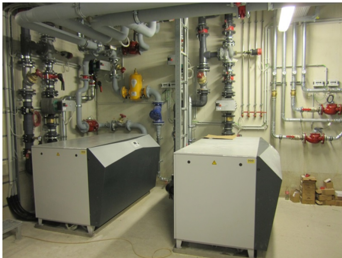
Abbildung 56: Ansicht der Heizzentrale bzw. der Wärmepumpen (linke Abbildung) und Darstellung der Verteiler und der Verrohrung der Rohrregister für den Erdspeicher (rechte Abbildung). Quelle: AIT
