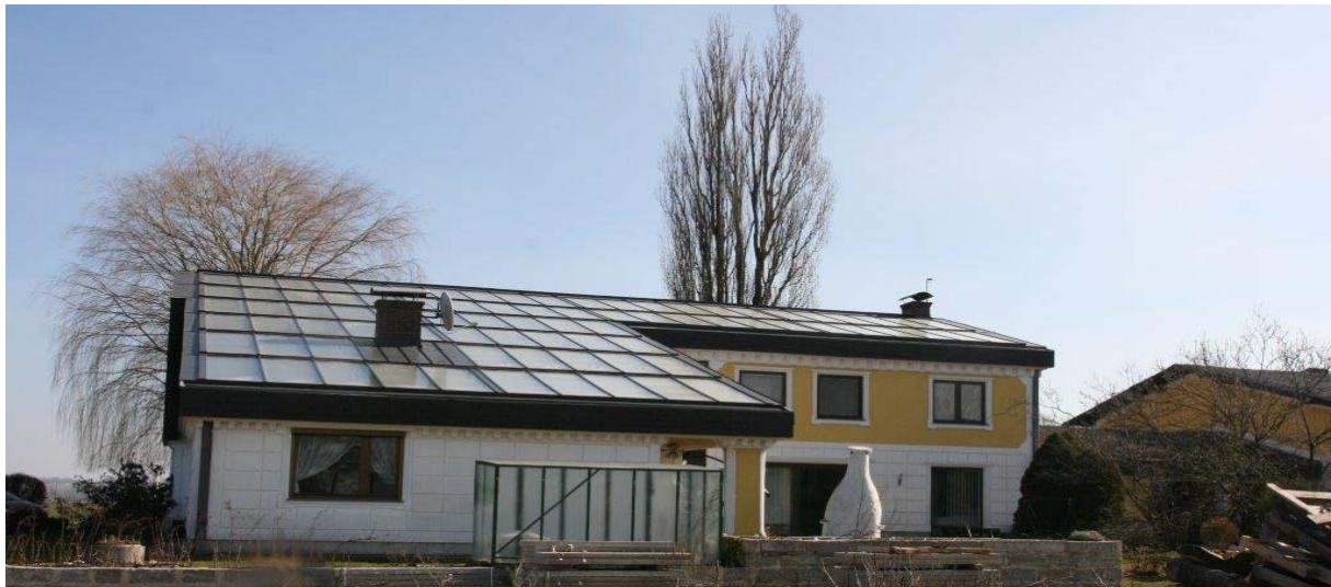
Abbildung 77: Ansicht des Wirtschaftsgebäudes bzw. des Kollektorfeldes der Anlage „Solare Trocknung Schickmaier“ (rechte Abbildung) sowie Ansicht des 30 m 3 Pufferspeichers während der Installation im Jänner 2015 (linke Abbildung) (Quelle: Schickmaier).
