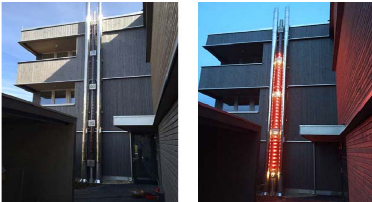
Abbildung 84: Darstellung des „Solarthermometers“ an der Fassade der Anlage „Wohnanlage Lexengasse“ (Bildquelle: TB Stampfer)
