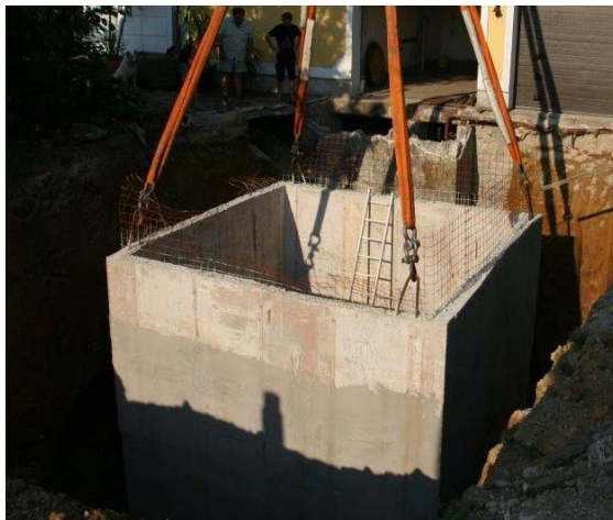
Abbildung 78: Darstellung des 30 m 3 Pufferspeicher während der Errichtung auf dem Betriebsgelände des landwirtschaftlichen Betriebs Schickmaier (Quelle: Schickmaier).
