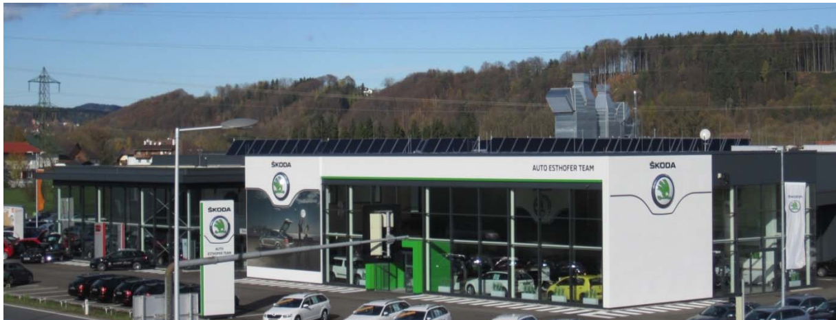
Abbildung 54: Südost-Ansicht des Gebäudes „Autohaus Esthofer“ mit den Kollektoren am Flachdach. Quelle: AIT
