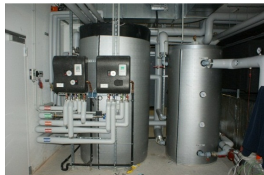
Abbildung 29: Aufständerung der Kollektorreihen am Dach des Büro- und Fertigungsgebäudes (linkes Bild). Pufferspeicher für Heizung und Warmwasserbereitung (rechtes Bild) (Bildquelle: AEE INTEC).
