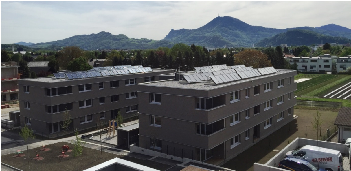
Abbildung 83: Ansicht zweier Wohngebäude und der auf dem Flachdach installierten Kollektorfelder der Anlage „Wohnanlage Lexengasse“ (Bildquelle: TB Stampfer)
