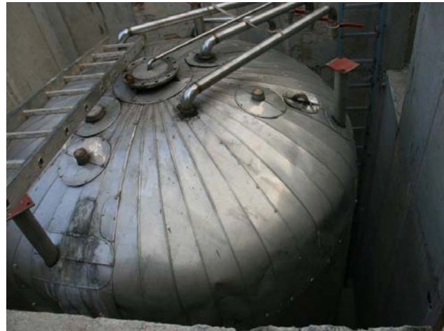
Abbildung 78: Darstellung des 30 m 3 Pufferspeicher während der Errichtung auf dem Betriebsgelände des landwirtschaftlichen Betriebs Schickmaier (Quelle: Schickmaier).
