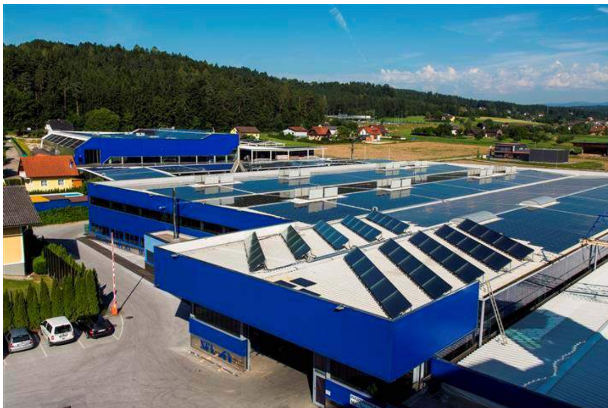
Abbildung 53: Ansicht des Betriebsgeländes der Fa. SFL technologies GmbH. Im vorderen Teil ist das Kollektorfeld am Flugdach der bestehenden Fassadenbauhalle (Bildquelle: Firma H. Traussnigg GmbH).
