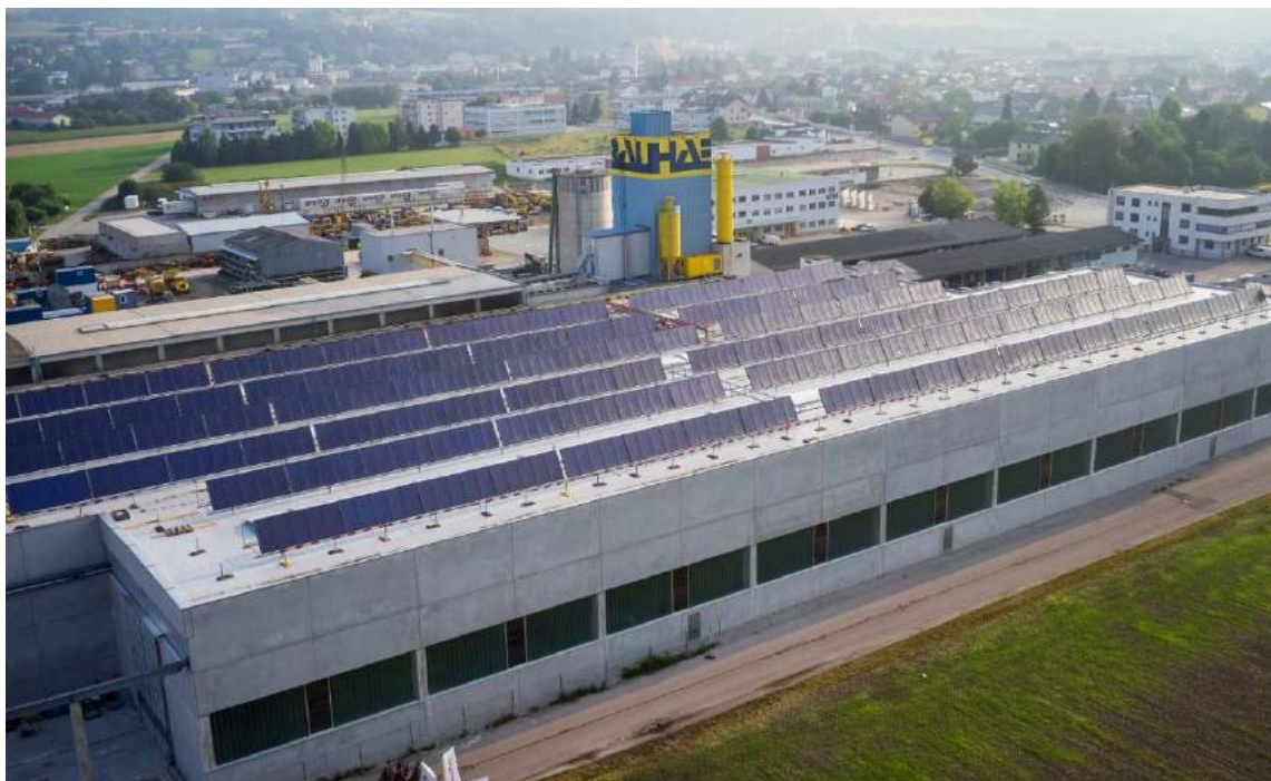
Abbildung 7: Ansicht der Fertigungshalle mit den aufgeständerten Kollektoren (Bildquelle: www.kuster.co.at )
