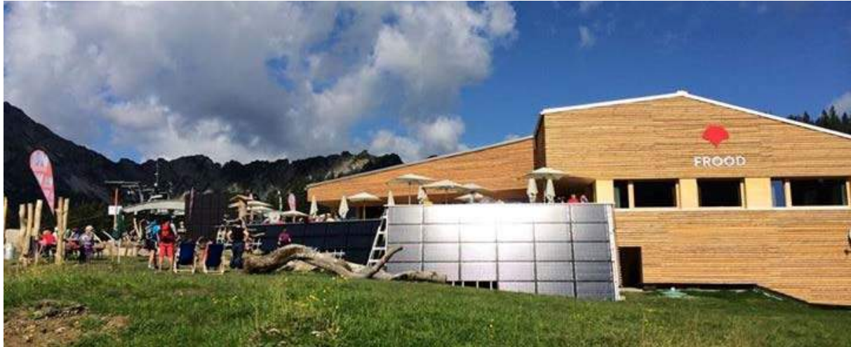
Abbildung 30: Ansicht des Bergrestaurants „Burtschasattel“ inkl. Ansicht des Hybridkollektorfeldes in der Fassade des Bergrestaurants im Vordergrund der Abbildung (Quelle: Frödd)
