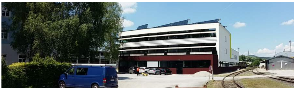
Abbildung 121: Ansicht des Gebäudes der ÖBB-Lehrwerkstätte mit dem Kollektorfeld am Dach des Gebäudes (Bildquelle: ÖBB)
