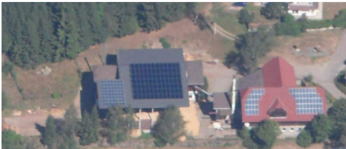
Abbildung 96: Nahwärme Sirnitz mit Solarthermie- und Photovoltaik-Kollektoren. Quelle: Einreichunterlagen
