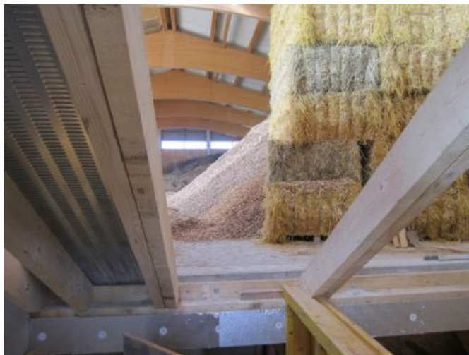
Abbildung 106: Ansicht von unten des zum Zeitpunkt der Aufnahme noch in Bau befindlichen Schrägrosts. Quelle: AIT
