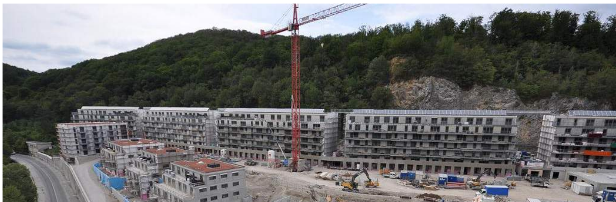
Abbildung 73: Ansicht der Wohnanlage „Waldmühle Rodaun“ während den Bauarbeiten mit Ende 2015 (Bildquelle: www.mrgu.at )
