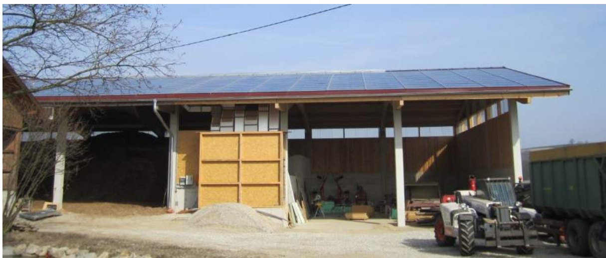
Abbildung 101: Süd-Ansicht der Halle mit der Luftkollektoranlage. Quelle: AIT
