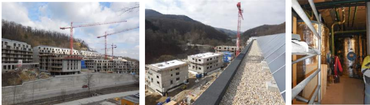
Abbildung 74: Ansicht der Wohnanlage „Waldmühle Rodaun“ während den Bauarbeiten mit Ende 2015 (Bildquelle: www.mrgu.at )
