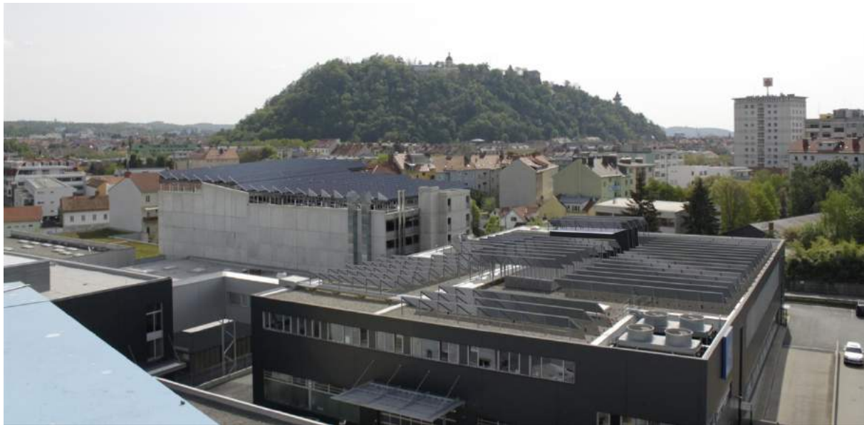
Abbildung 112: Rendering beider Kollektorfelder der Anlage AVL. Im Vordergrund das 1.400 m 2 große Kollektorfeld am Dach des APZ-Gebäudes bzw. im Hintergrund das 1.580 m 2 große Kollektorfeld am Dach der Parkgarage. (Bildquelle: S.O.L.I.D. Gesellschaft für Solarinstallation und Design m.b.H.)
