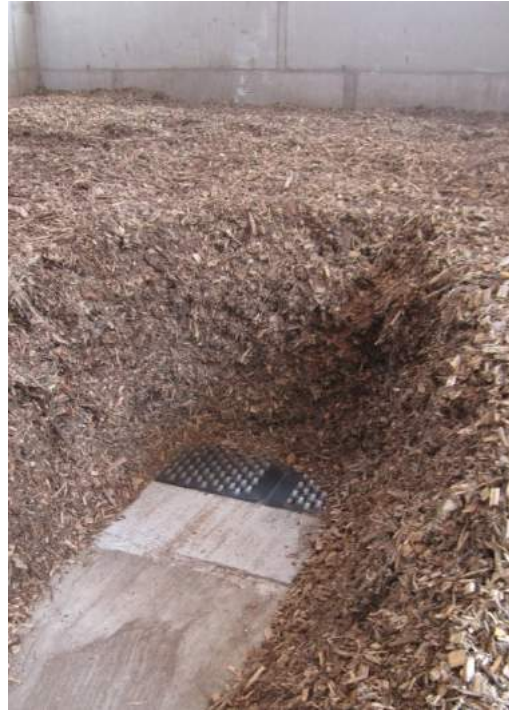
Abbildung 109: Mit Hackschnitzel beladener Flachrost. Rost zur Demonstration teilweise freigelegt. Quelle: AIT
