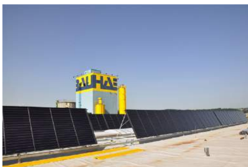
Abbildung 8: Aufständigung der Kollektorreihen am Dach der Fertigungshalle (Bildquelle: Linke Abbildung: www.gasokol.at , Rechte Abbildung: HABAU)
