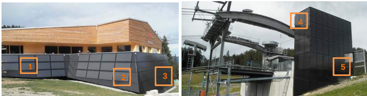
Abbildung 31: Darstellung der einzelnen Kollektorfelder der Anlage „Brandnertal Gastronomie“. Linkes Bild zeigt die beiden thermischen Flachkollektorfelder (1 und 2) sowie ein Hybridkollektorfeld (3). Rechte Abbildung zeigt zwei Hybridkollektorfelder an der Fassade der Bergstation (4 und 5) (Bildquelle: www.solartor.cc ).
