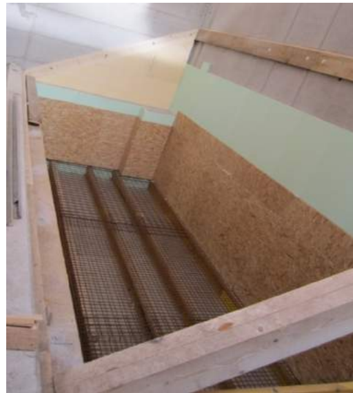
Abbildung 105: Steinspeicher – zum Zeitpunkt der Aufnahme noch im Bau befindlich, daher noch ohne Steine – der sich unter dem noch nicht fertiggestellten Schrägrost befindet. Die Luft wird durch das Gitter von unten in den Speicher geblasen (grün: Dämmschicht). Quelle: AIT
