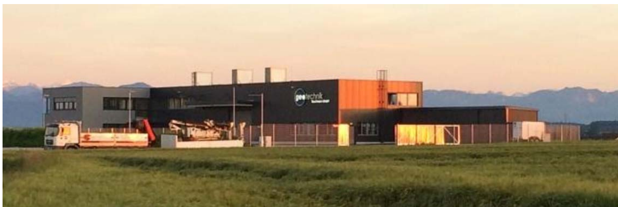
Abbildung 91: Gebäude „Geotechnik Tauchmann“, hier noch ohne Solarkollektoren. Quelle: http://www.geotechnik.org
