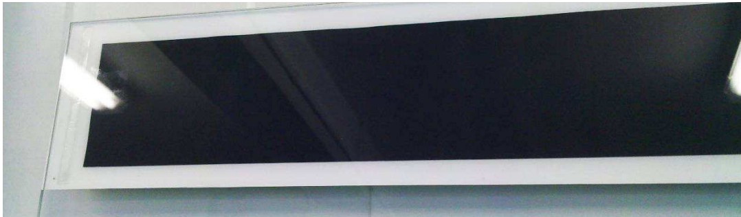
Abb. 25: Bruchfreie Lamination der Dünnschichtsolarfolien
