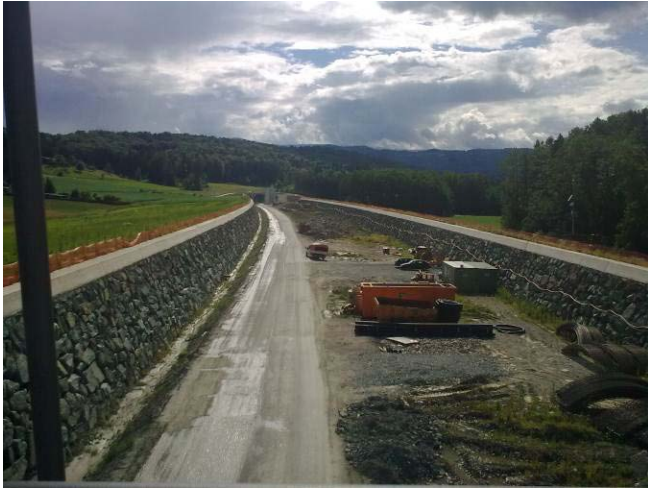
Bahnachse in Bau im Schwerpunkt der neuen Zukunftsstadt
