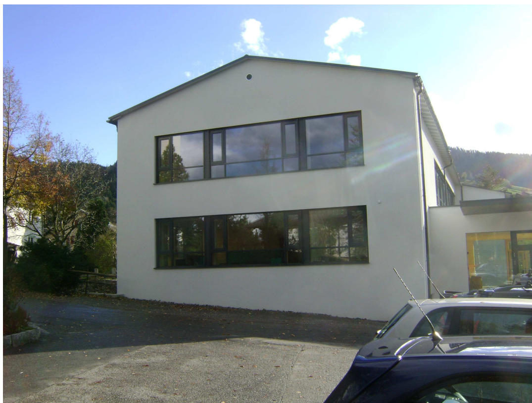
Abb.16 Volksschule nach der Sanierung
