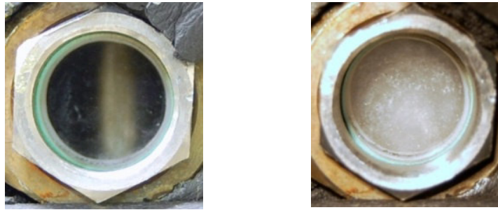
Abbildung 4-1: Schauglas im unteren Teil des Verdampfers: links – normaler Betrieb; rechts – Entstehung von \text{NaOH} -Kristallen
