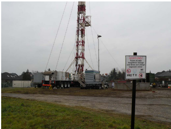
Abbildung 5: Beginn des Sondenumbaus
