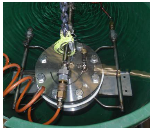
Abbildung 19: Überprüfung der Dichtheit der gefertigten Pumpe für die Vorversuche am IWT (Kotnig, 2011a)
