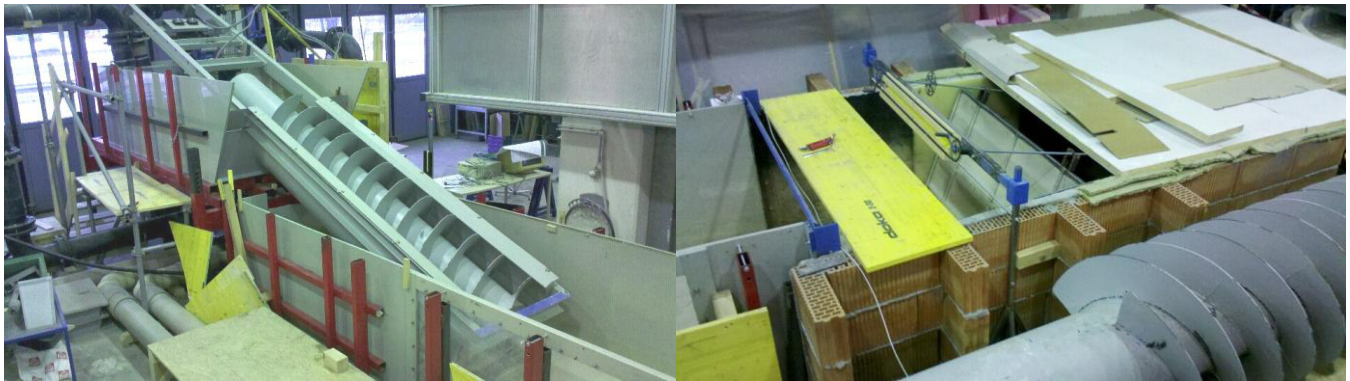
Abbildung 13: Fertiger Aufbau der Wasserkraftschnecke und der Wehranlage zur Unterwasserregulierung
