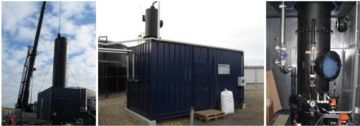
Abbildung 1: Die Lieferung und Aufbau des chemisch-oxidativen Wäschers an der Biogasanlage Bruck an der Leitha
