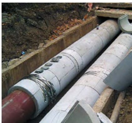
Abbildung 13 Anwendungen von PUR/PIR-Schäumen. Diese Materialien werden bereits zur Isolierung von Fernwärmeleitungen verwendet und können mechanisch gut bearbeitet werden (Schneiden, Fräsen, Thermoformen).
