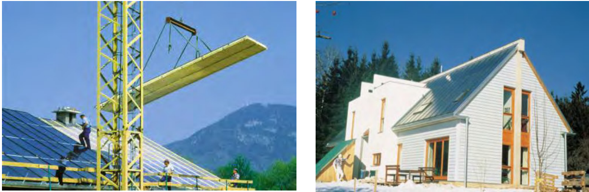
Abbildung 21: Modulare Dachelemente für solarthermische Paneele mit oder ohne Dachfenster
