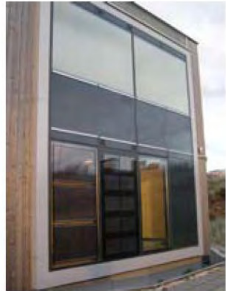
Abbildung 19: Transparenter solarthermischer Kollektor (links), (Quelle: ISE, Deutschland)
