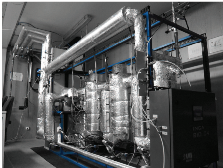
Abbildung 15: Fotografie des Versuchsaufbaus der dreistufigen WGS-Anlage im BKW Oberwart (Fail S.,2014).
