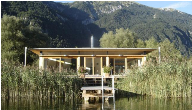
Abbildung 25: Schwimmendes Saunahaus am Pressegger-See mit 60 cm starken Styropor-Schwimmkörpern
