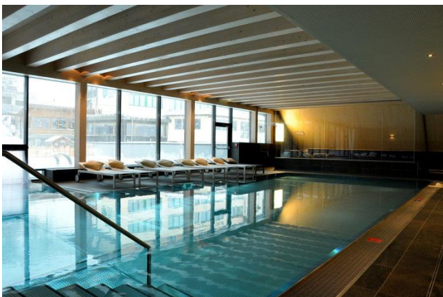
Abbildung 23: Hotel „Sonnenalpe Nassfeld“ mit sichtbarer Holzbalkendecke, Spannweite ca. 8,5 m.
