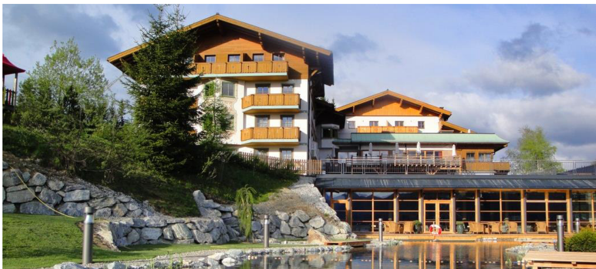
Abbildung 34: „Hotel Edelweiss“ in Wagrain mit neuem Schwimmbad in der untersten Ebene samt Teich
