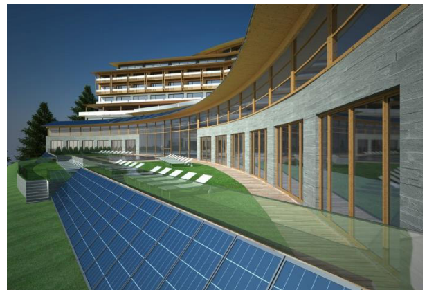
Abbildung 17: „For Friends Hotel“, Mösern; Kollektoren am und als Geländestufe (nicht realisiertes Wettbewerbsprojekt).
