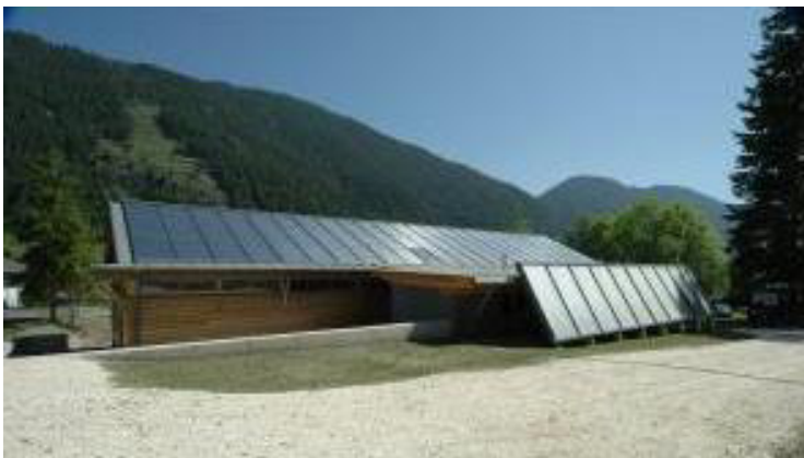
Abbildung 16: Sanitärgebäude „Camping Knaller“; südliche Dachfläche mit thermischen Kollektoren bestückt, Warm-Wasserspeicher deckt 100 % des Brauchwassers ab.
