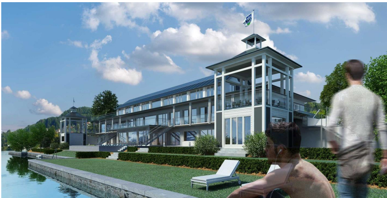
Abbildung 13: „Kärntner Badehaus“ in Millstatt in PH- und Holzbauweise mit Solarthermie und PV-Anlage
