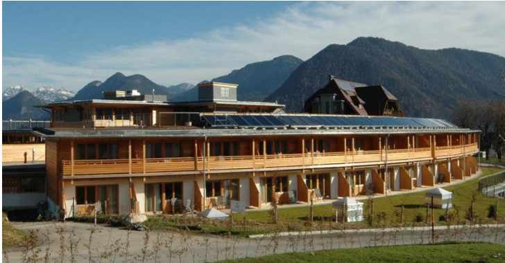
Abbildung 14: Hotel „Die Wasnerin“ Bad Aussee; die südwestliche Hälfte des Atriums ist mit thermischen Kollektoren für die Schwimmbadheizung bestückt.
