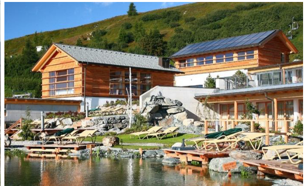
Abbildung 15: Erweiterung „Mountain Resort Feuerberg“, Gerlitzen; dachintegrierte thermische Solarkollektoren zur Erwärmung des Badeteiches.
