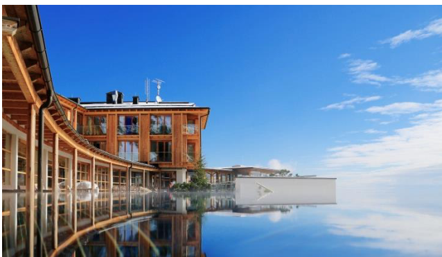
Abbildung 29: „Mountain Resort Feuerberg“ - sämtliche Wellness-erweiterungen wurden in konstruktivem Holzbau errichtet.
