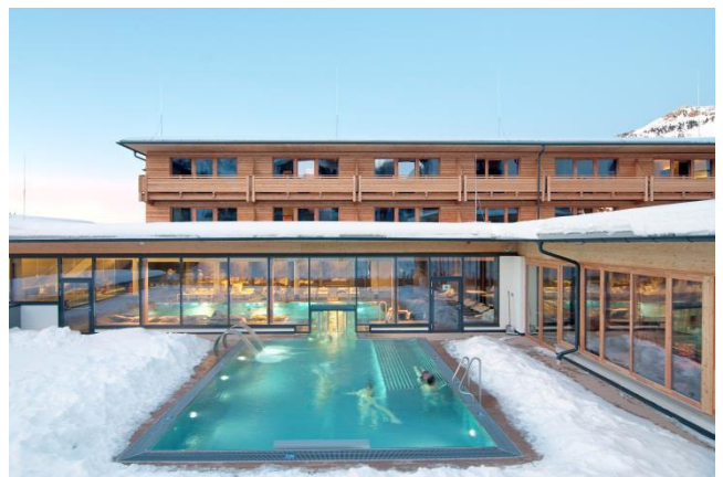
Abbildung 24 : Neben dem Schwimmbad wurden auch zwei bis drei Bettengeschoße aus konstruktivem Holzbau errichtet .
