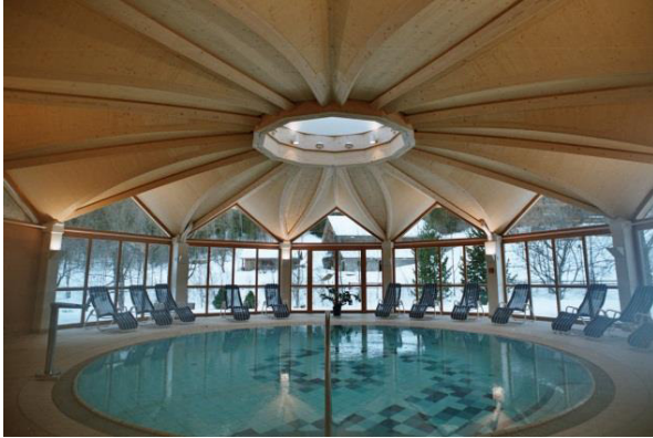
Abbildung 21: Schwimmbad „Kärntnerhof“ als „bionische“ Holzkonstruktion. Als Vorbild dient eine 12-blättrige Blüte.
