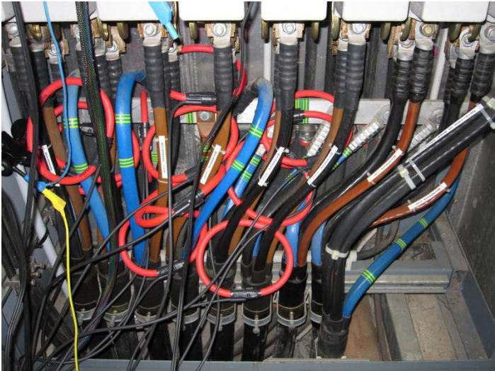
Abbildung 4: Messwertaufnehmer am Niederspannungsabgang links, 16-Kanal Messsystem rechts
