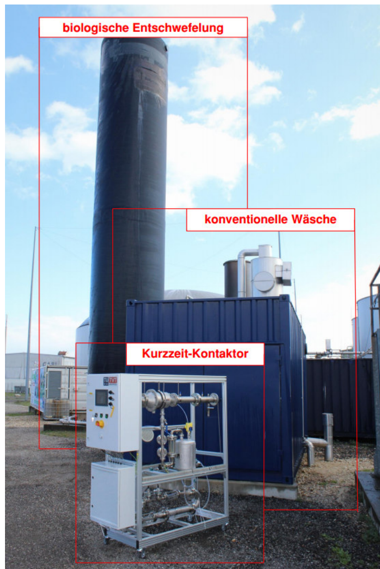
Abbildung 20: Größenvergleich bestehender Entschwefelungstechnologien (biologische Wäsche, klassische chemisch-oxidative Wäsche, Kurzzeit-Kontaktor – die Kapazität des Kurzzeit-Kontaktors ist max. 200 m 3 /h und damit ca. ¼ der Kapazität der anderen Technologien, der hochgerechnete Platzbedarf für 800 m 3 /h jedoch unwesentlich größer)
