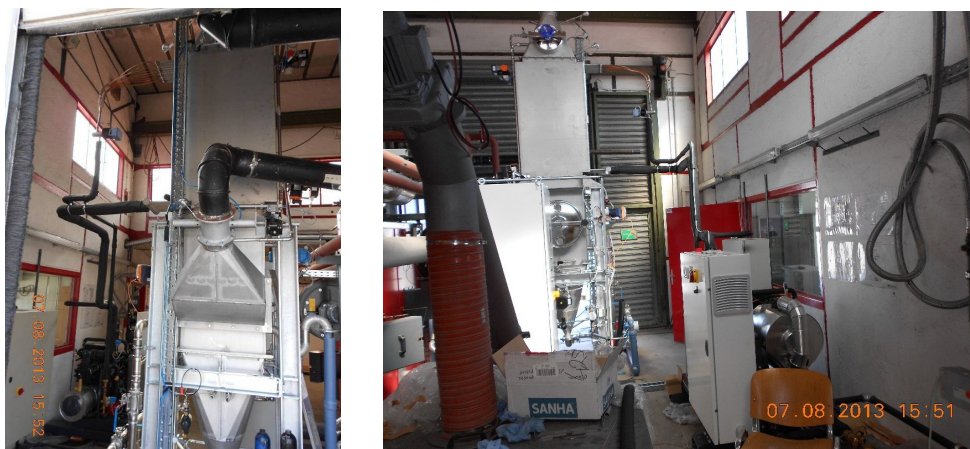
Abbildung 16: Inbetriebnahme der Wärmepumpe
