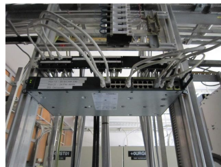
Abbildung 21: (a) Zentraler Fernwirkkopf im UW; (b) Kommunikationsverbindungen Fernwirkkopf, Trafostationen, Kraftwerke, Prozessrechner
