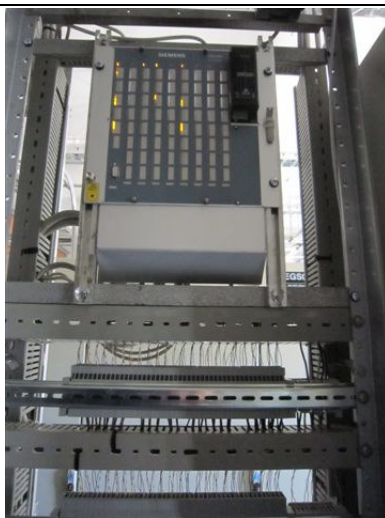
Abbildung 21: (a) Zentraler Fernwirkkopf im UW; (b) Kommunikationsverbindungen Fernwirkkopf, Trafostationen, Kraftwerke, Prozessrechner
