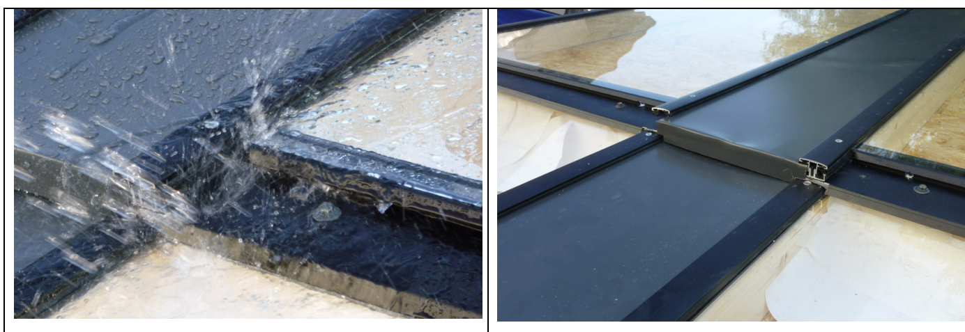
Abbildung 5: Durchgeführter Beregnungstest (Schlagregen) des Put&Click Indachsystems
