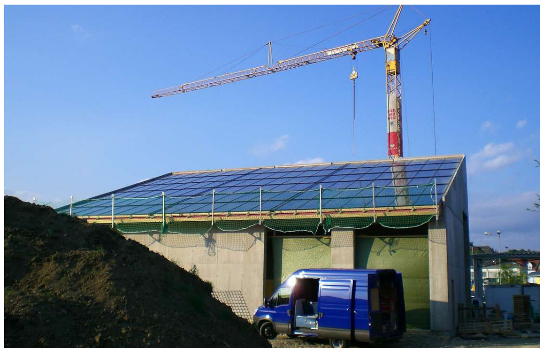
Abbildung 27: Erfolgreich umgesetztes Indachsystem (rund 280m 2 Kollektorfläche)
