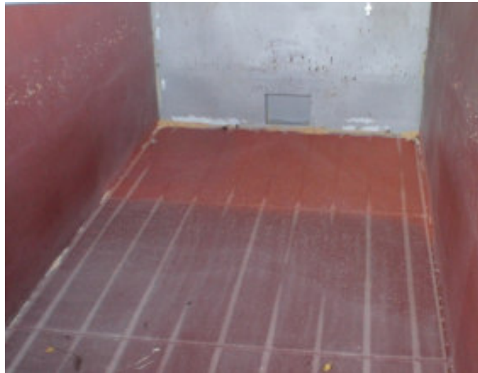
Abbildung 2-16 Innenraum von Container mit Lochboden
