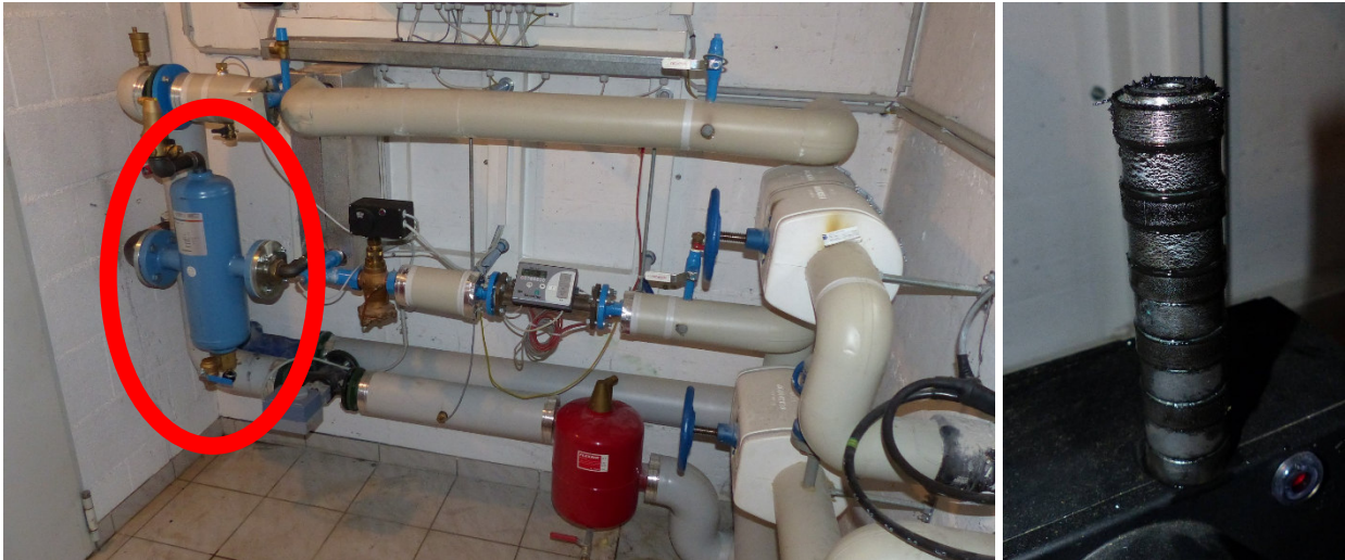
Abbildung 10: Verringerung der Rücklauftemperatur durch bessere Wasserqualität
