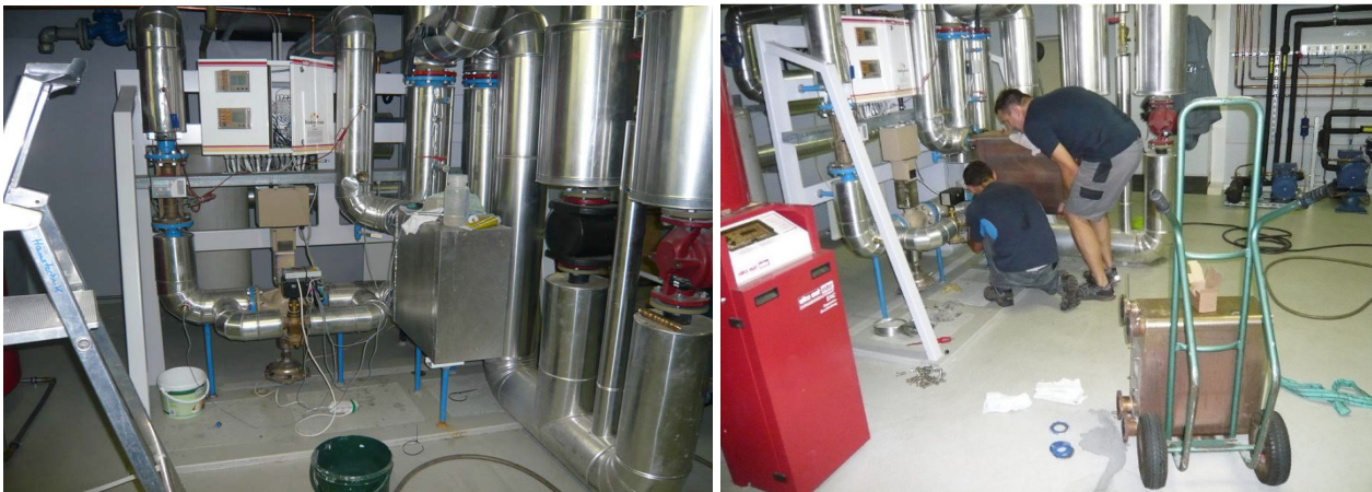
Abbildung 11: Größere Umbaumaßnahmen bei einer Wärmeübergabestation
