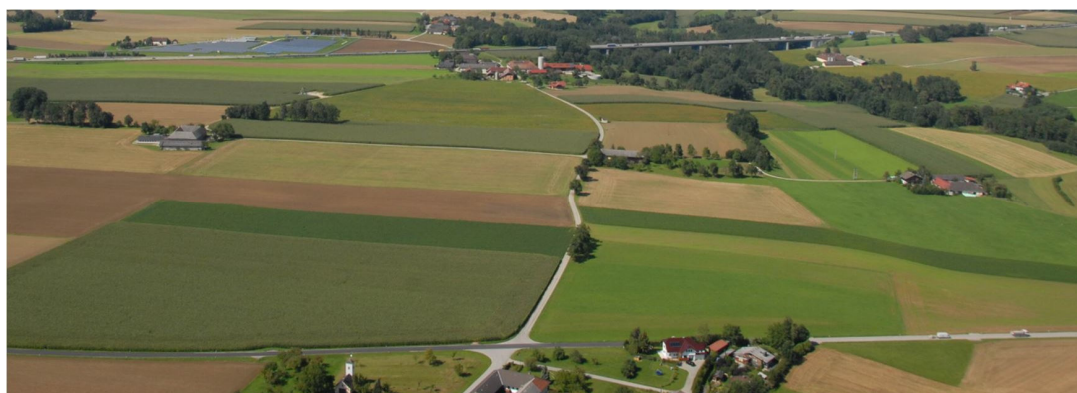
Abbildung 11: Ortsnetz Littring mit eingezeichneten PV-Anlagen und Spannungsqualität Messstellen.
