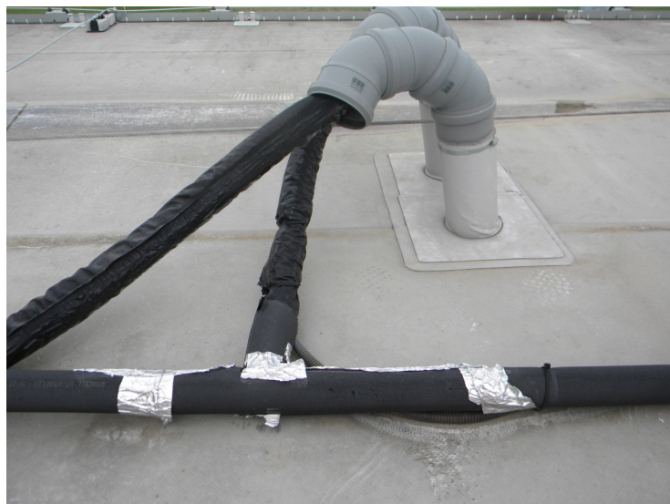
Abbildung 26 Aussendämmung ohne UV Schutz, ohne Verbissschutz und zu geringe Dämmstärke = negativer Standard
