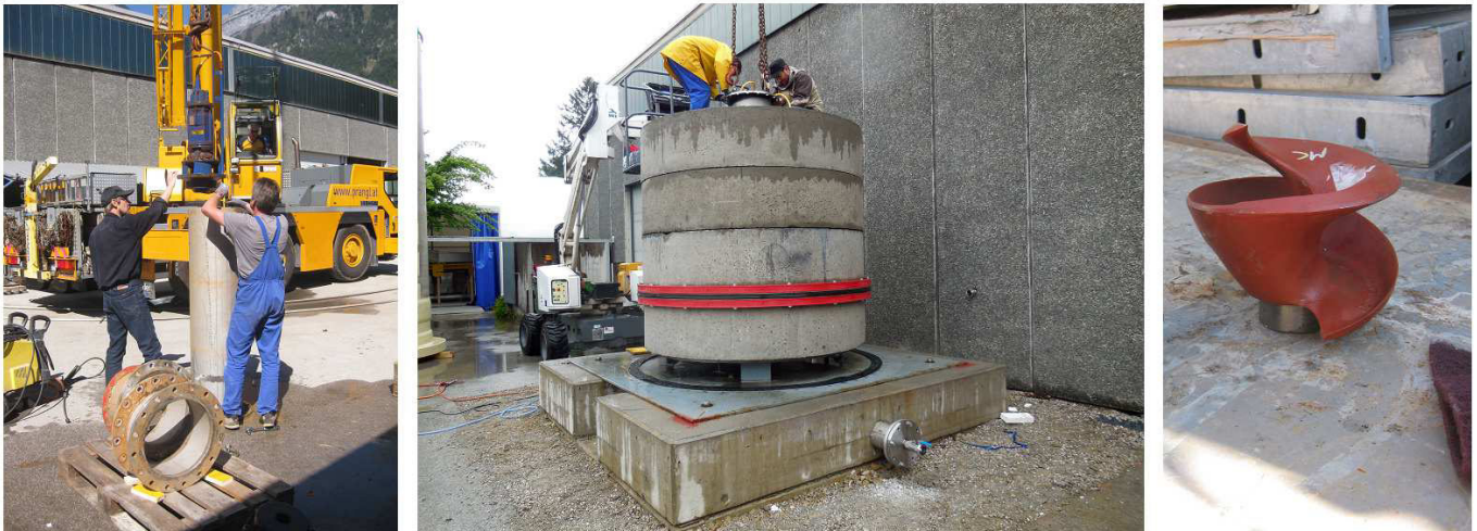
Abb. 7: Einbau der Pumpe
