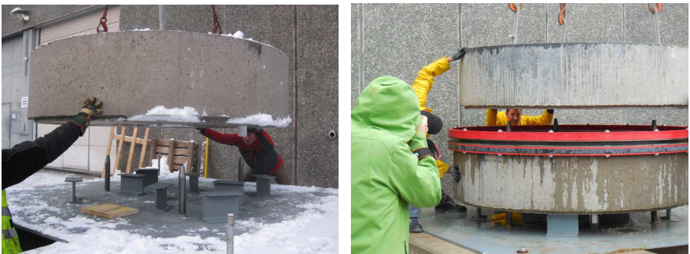
Abb. 5: Positionierung der Schwebbetonringe
