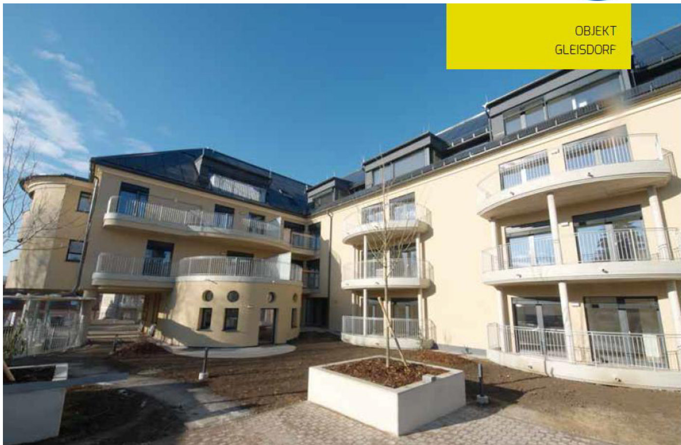
Abbildung 21: Das Gebäude des Seniorenheims Gleisdorf nach der Sanierung
