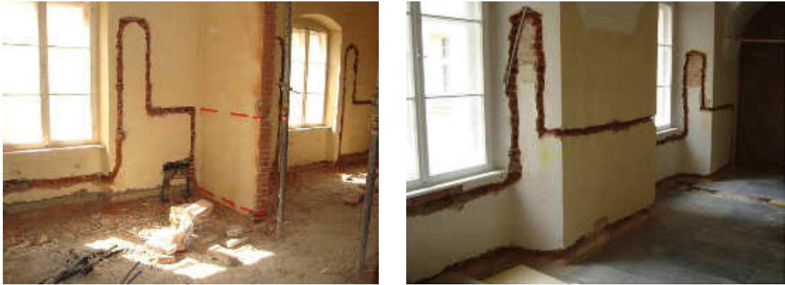
Abb. (365) Wandheizung Franziskanerkloster - eingestämmt (Knüppel, Broidler, & Knotzer, Franziskanerkloster Graz - erfolgreich auf dem Weg zum Nullemissionskloster, 2012)
