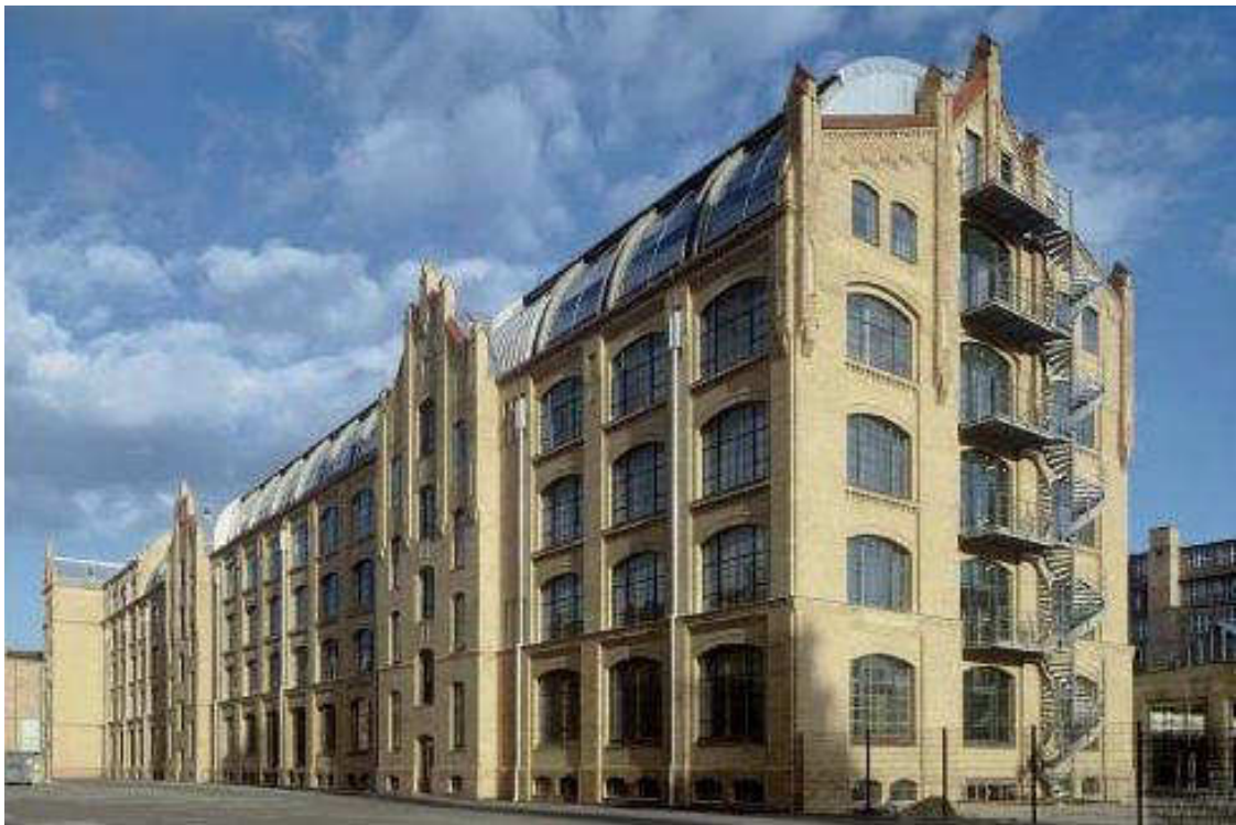
Abb. (250) Das Gebäude A am Wilhelminenhof (Augustin, F. (c), o.A).
