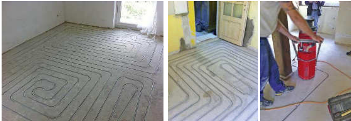
Abb. (362) Die Fußbodenheizungsrohre werden direkt in den gefrästen Estrich eingelegt (IKZ, 2012)
