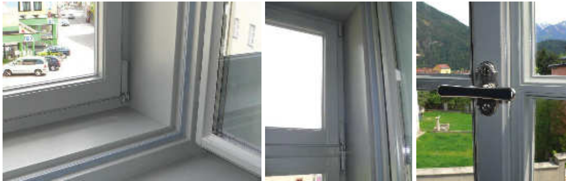
Abb. (353) Nachbau von Kastenfenster mit Isolierverglasung und „Drehkipp Funktion“ (ZP-System (a), o.A., S. 34f)
