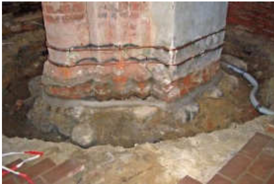
Abb. (364) Stützentemperierung unverputzt und verputzt (Dr. Scheffler & Partner GmbH (c), o.A.)
