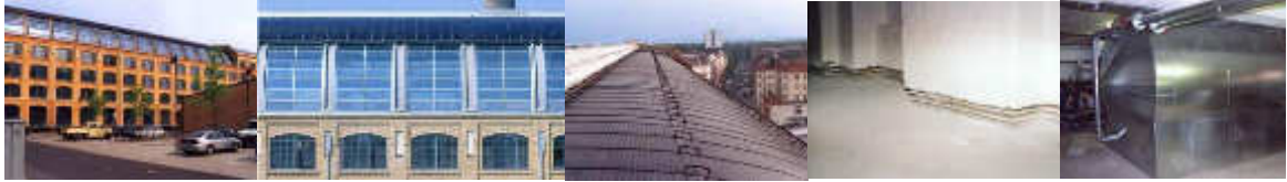
Abb. (251) Solarthermieranlage am Gebäude A des Campus Wilhelminenhof. 2. und 4. Foto von li. (Augustin, F. (b), 2003), restliche Fotos von (Corona Solartechnik GmbH, 2007).
