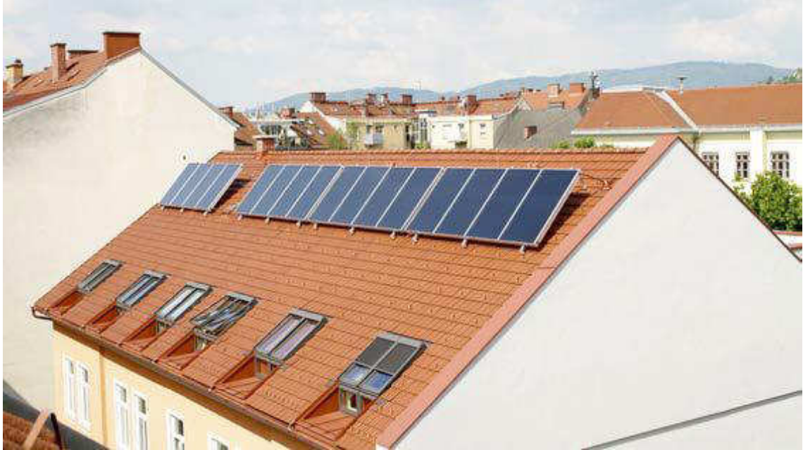
Abb. (372) Aufdachmontage von Solartechnologien (IGL, 2011)
