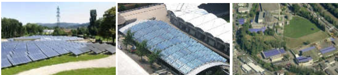
Abb. (378) Großanlagen in Graz (S.O.L.I.D. Gesellschaft für Solarinstallation und Design mbH, 2011)
