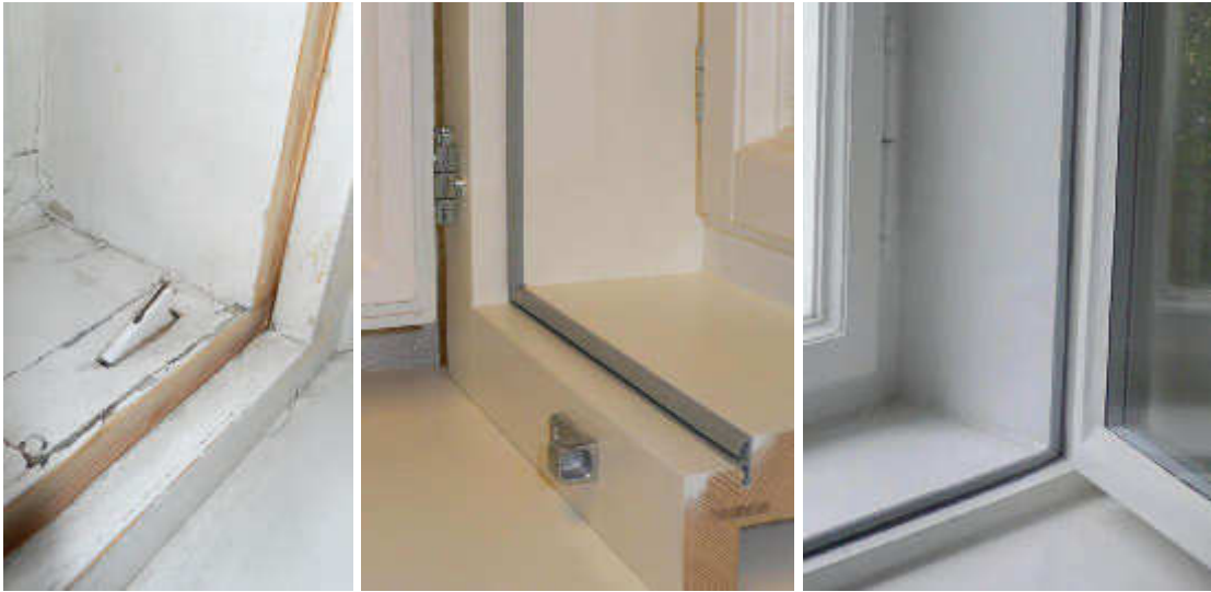
Abb. (348) Dichtungseinbau in Altbaufenster (ZP-System (a), o.A., S. 27)
