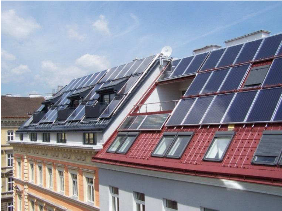
Abb. (263) Hotel Wilhelmshof in Wien, Gründerzeitgebäude (Sonnenkraft Österreich, 2012).
