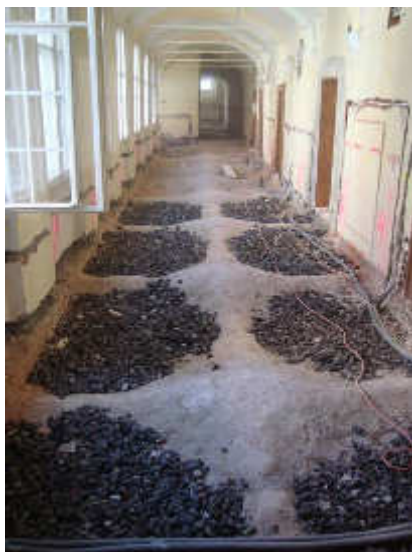
Abb. (394) Schaumglasschotter im Gangbereich (Knotzer A.)
