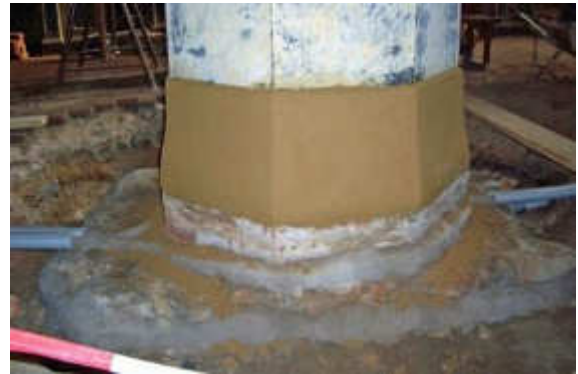
Abb. (364) Stützentemperierung unverputzt und verputzt (Dr. Scheffler & Partner GmbH (c), o.A.)
