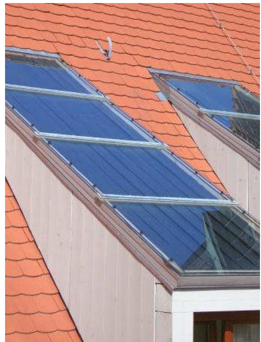
Abb. (247) Solarthermiegaupen der evangelischen Akademie St. Afra (Pfau Architekten (a), 2012).
