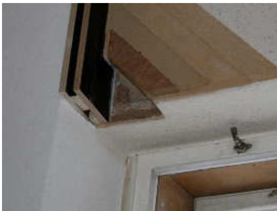
Abb. (343) Links: Leibungsdämmung über Oberlichte, Schönbrunngrasse Rechts: Veränderung der Fensteröffnung
