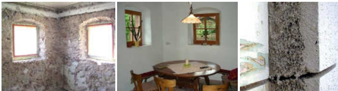
Abb. (336) Zellulosedämmung vor der Sanierung und nach der Sanierung (S.O.L.I.D. Gesellschaft für Solarinstallation und Design mbH, 2011, S. 3-49) (links und mitte) Rauhe Oberfläche von einer Zellulosedämmung mit Putz (S.O.L.I.D. Gesellschaft für Solarinstallation und Design mbH, 2011, S. 3-46) (rechts)
