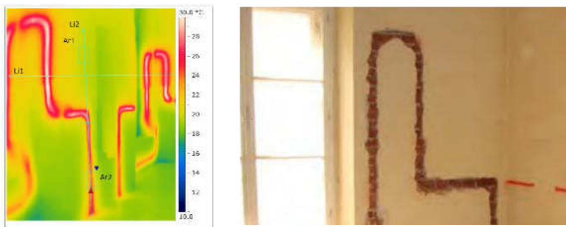
Abb. (151) Thermografische Aufnahme nach der Inbetriebnahme und Verlegeschlitzte im Zuge der baulichen Integration. Datenquelle des Bildmaterials: Thermografiebericht Projekt „denkmalaktiv I“
