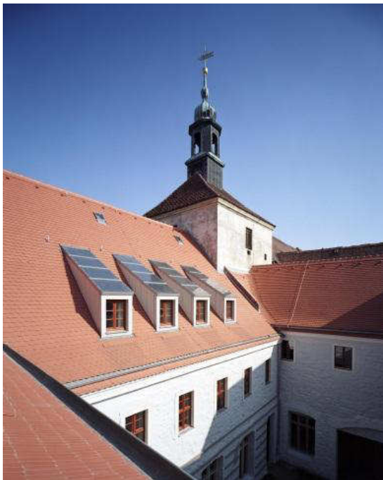
Abb. (247) Solarthermiegaupen der evangelischen Akademie St. Afra (Pfau Architekten (a), 2012).
