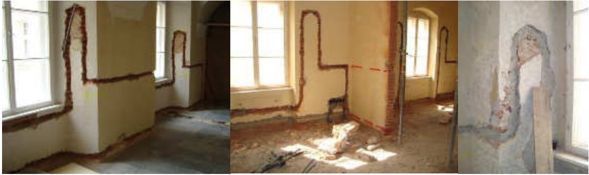
Abb. (399) eingestemmte Bauteilheizung im Franziskanerkloster (Knotzer A.)
