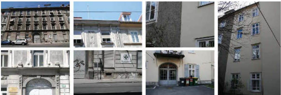
Abb. (277) Gründerzeitblock Außenansichten
