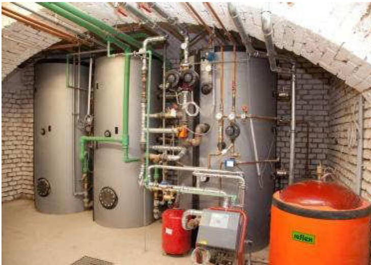
Abb. (260) Solarthermieanlage des Gründerzeitgebäudes Wißgrillgasse (Gassner & Partner Baumanagment GmbH, 2012).
