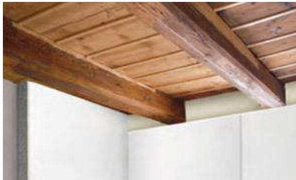
Abb. (340) Absetzen der Dämmung unter einer Holzbalkendecke (Rigips, o.A.)
