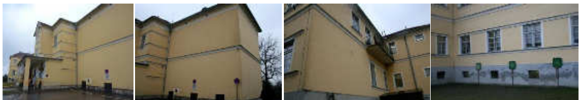
Abb. (291) Lage des Schulgebäudes im Grazer Stadtraum (oben) Stadtstruktur (unten) (bing_maps) und Fassade
