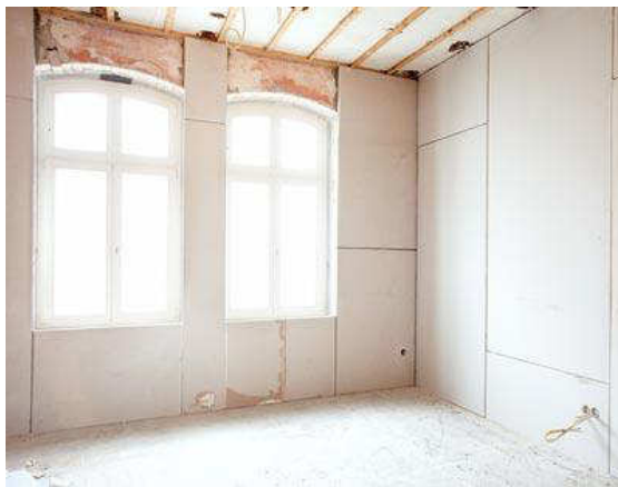
Abb. (334) Links: Innendämmsystem Platte roh Quelle (baulinks, 2010) und rechts: Innendämmsystem Platte mit finaler, getrichener Oberfläche (Rockwool GmbH, 2010)
