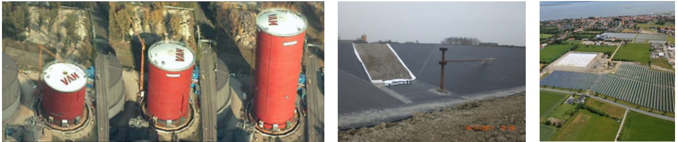
Abbildung 1: (links) Wärmespeicher des Fernwärmenetzes in Linz (Quelle: www.vam.at ); (mitte/rechts) Erdbecken-Wärmespeicher in Marstal (sunstore IV), (Quelle: Marstal Fjernvarme)
