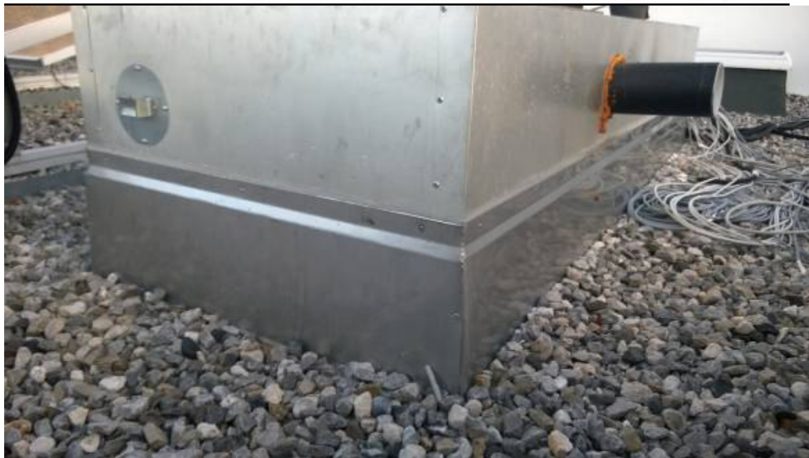
Abbildung 83 Sockelanschlussdetails II
