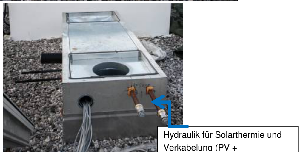
Abbildung 82 Sockelanschluss-Details I
