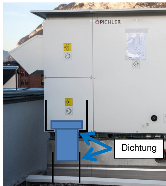
Abbildung 81 Dichtung Anschluss Dach
