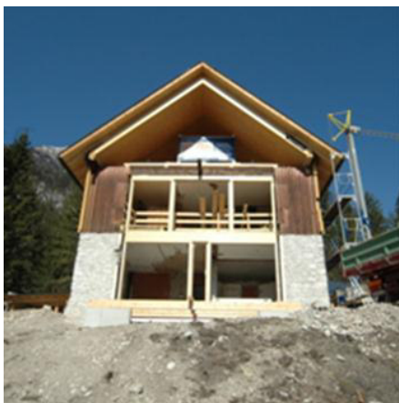
Abbildung 6: Öffnung der Südfront
