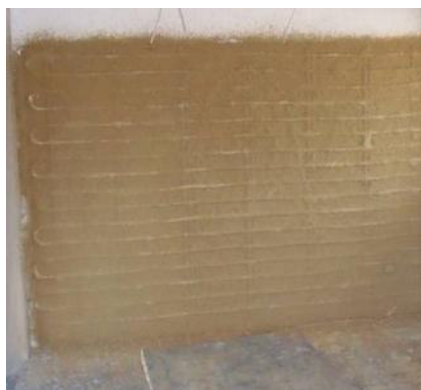
Abbildung 43: Wandheizung mit einer Lage Lehmputz
