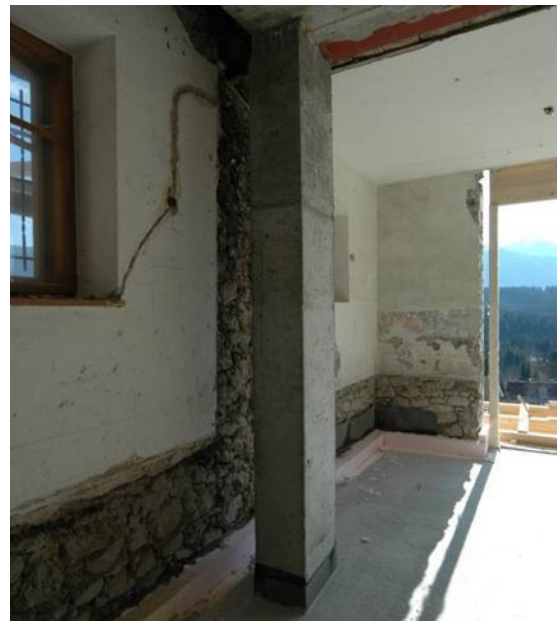
Abbildung 17: neue Decke und Stütze 30 cm vor der Außenwand
