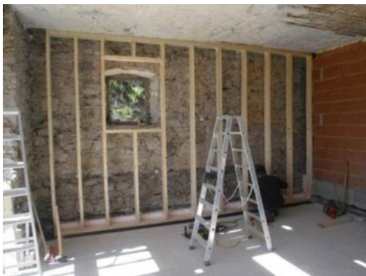
Abbildung 18: Tragende Holzvorsatzschale für die Innendämmung– Holzgerippe noch ohne Streuschalung
