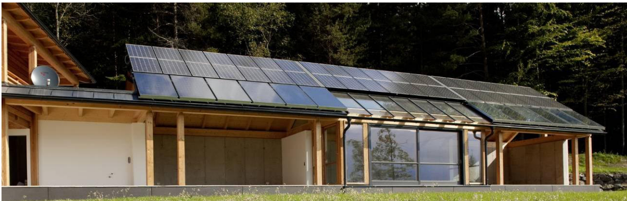
Abbildung 69: Solarthermie und Photovoltaik von Südwesten
