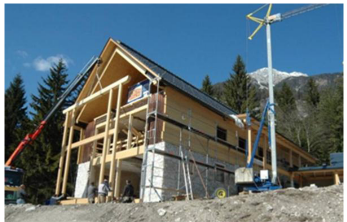
Abbildung 7: Primärkonstruktion Balkon, Holzweichfaserplatten montiert
