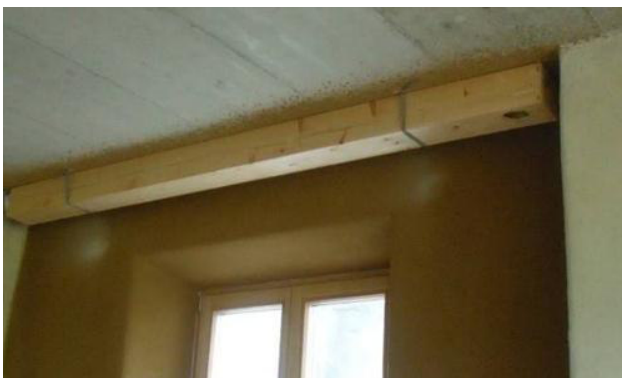
Abbildung 47: Zirbenholzkanal an der Decke des EG
