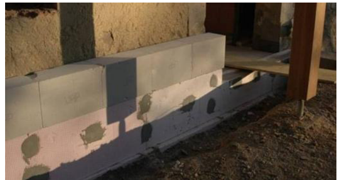
Abbildung 28: Unterhalb der XPS Platten wurde ein Unterbeton hergestellt, damit das Auflager für die Wand gegeben ist.
