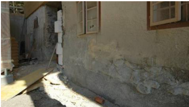
Abbildung 25: trockenengelegte Außenwand vor Herstellung der Außendämmung
