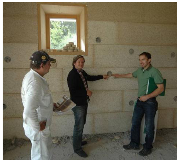
Abbildung 21: Dr. BUXBAUM, Ing. Bernd ZERZA, sowie Herr REISINGER (Fa. ISOCELL) beim Einbau der Messsonden .
