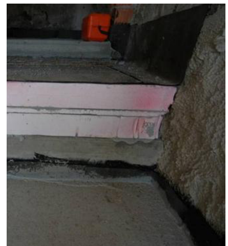
Abbildung 14: 30 cm Innendämmung
