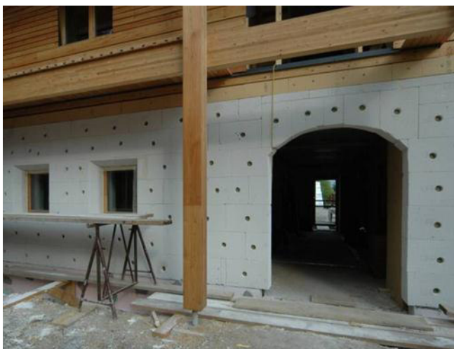
Abbildung 8: Alle Dübel wurden versenkt hergestellt und für die Wärmebrückenfreiheit mit Dämmörtel verspachtelt.
