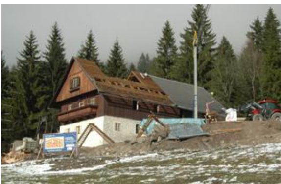
Abbildung 3: Abbrucharbeiten des alten Dachstuhles
