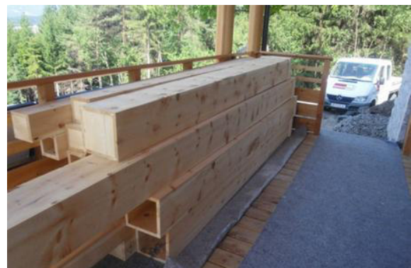
Abbildung 48: Zirbenholzkanäle nach Anlieferung vor Montage
