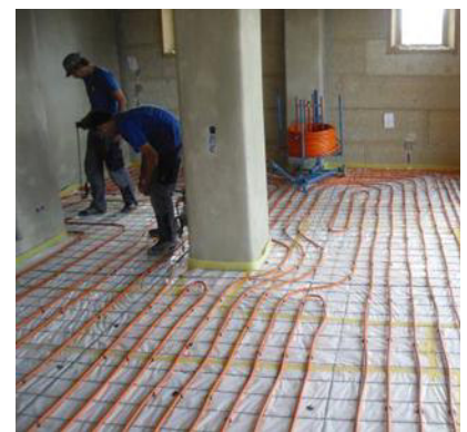
Abbildung 44: Fußbodenheizung im EG Verlegungsarbeiten
