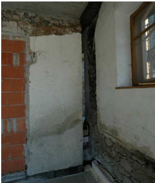
Abbildung 16: Durchtrennung Innen-/Außenwand
