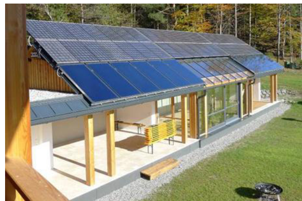
Abbildung 71: Glashaushaus vom Laubengang des Bestandsgebäudes aus fotografiert.
