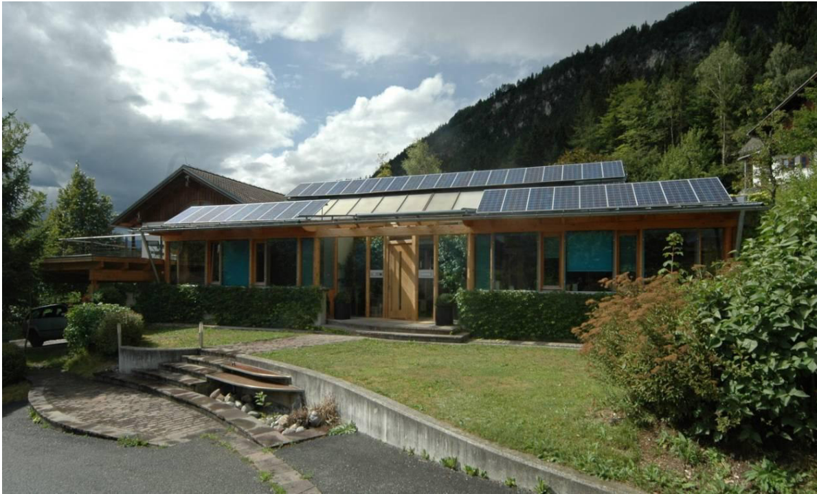
Abbildung 66: PV-Anlage 4 auf dem Dach des Architekturbüros Ronacher – Foto von Südosten
