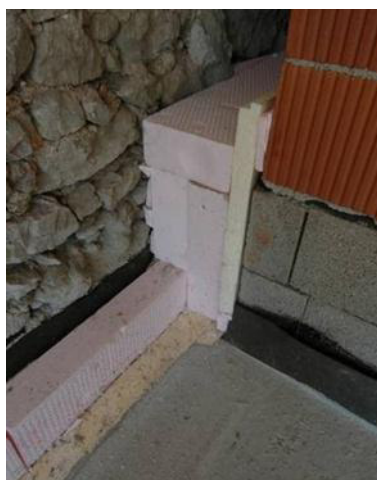
Abbildung 12: Fußbodendämmung 24 cm XPS Platten unterhalb des Unterbetons
