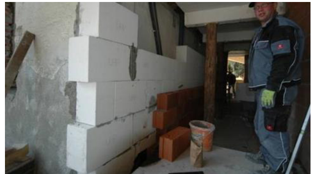
Abbildung 26: Mineralschaumplatten samt Vormauerung nach Durchtrennung der nördlichen Stahlbetondecke
