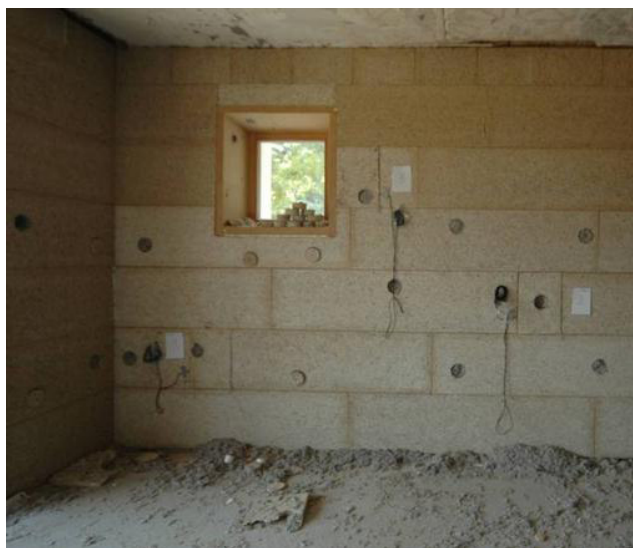
Abbildung 20: Einbau der Messsonden
