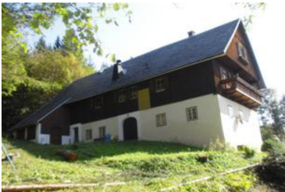
Abbildung 2: Altbestand vor Beginn der Baumaßnahmen
