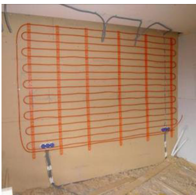
Abbildung 42: Wandheizung vor Aufbringen des Lehmputzes
