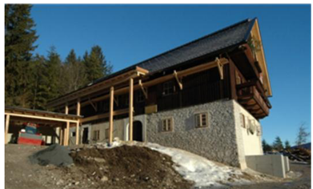
Abbildung 4: Baustellenfoto, Außenputz abgeschl., neues Dach
