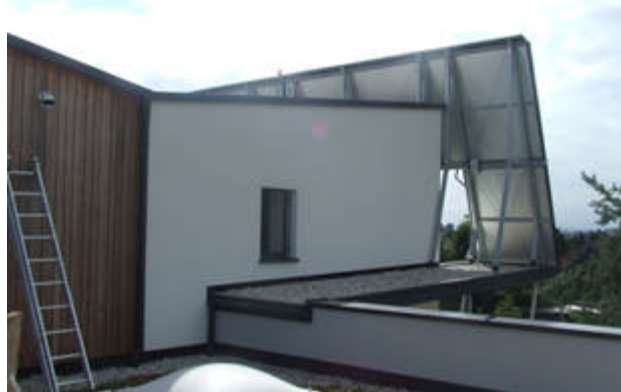
Abbildung 61: Fertig verlegte Bauteilaktivierung Decke Erdgeschoß (links); Südansicht des nahezu fertigen Gebäudes (rechts) (Quelle: Bauherr); Nordansicht der Solaranlage (unten, Quelle: AEE INTEC)
