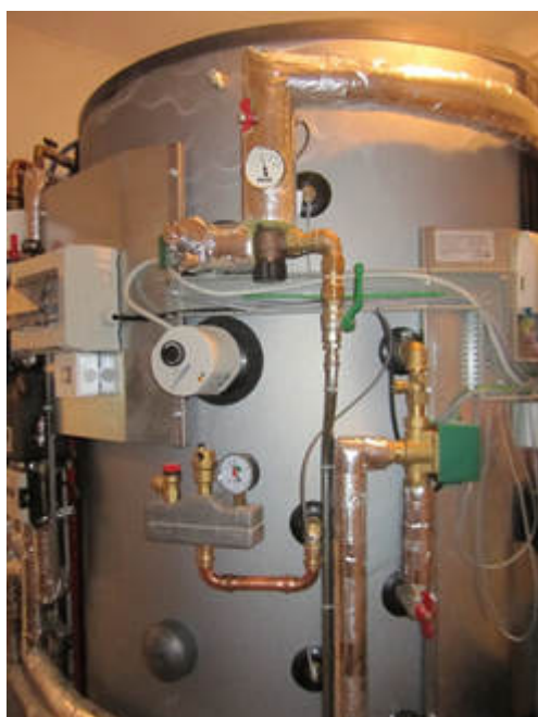
Abbildung 81: Linkes Bild: Kombispeicher mit Abbrandsteuerung (links), Elektroheizstab (Mitte); Rechtes Bild: Hauptteil des Stückholz-Kachelofens im Wohnzimmer (Quelle: AIT)
