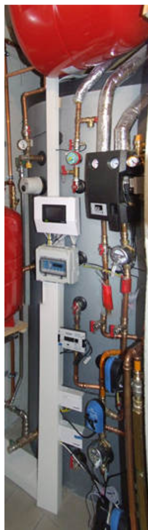
Abbildung 22: Solaranlage mit Einstrahlungssensor (oben links), Lüftungsanlage (unten links) und Pufferspeicher (rechts) (Bildquelle: AEE INTEC)
