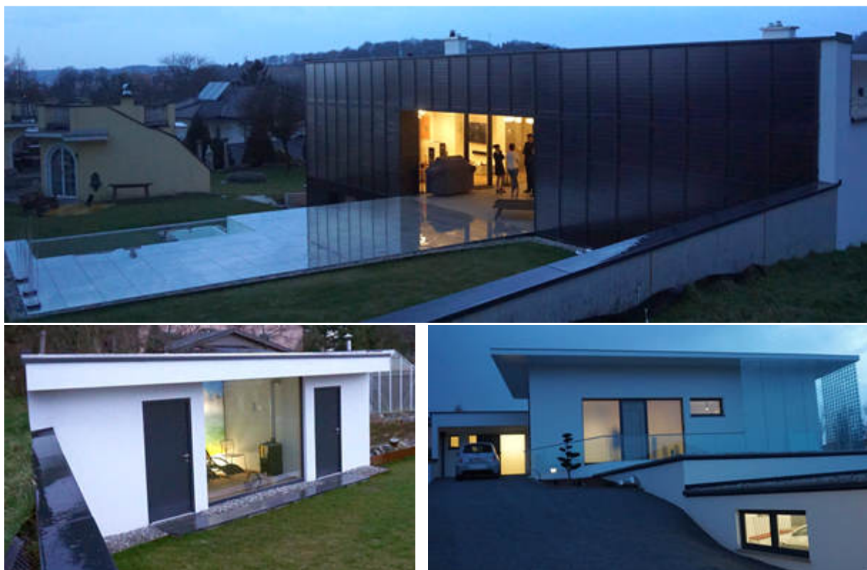
Abbildung 39: Südansicht (oben), Gartensauna (unten links) und Nordansicht inkl. semitransparenter PV-Anlage in der Südwest-Fassade (unten rechts) des Solarhauses Maier (Quelle: AEE INTEC)
