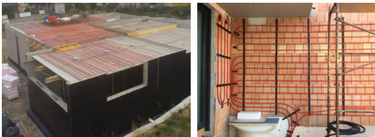
Abbildung 40: Verlegung der Bauteilaktivierung von Zwischendecke (links) und Nordwand (außenliegend, rechts) (Quelle: Bauherr)
