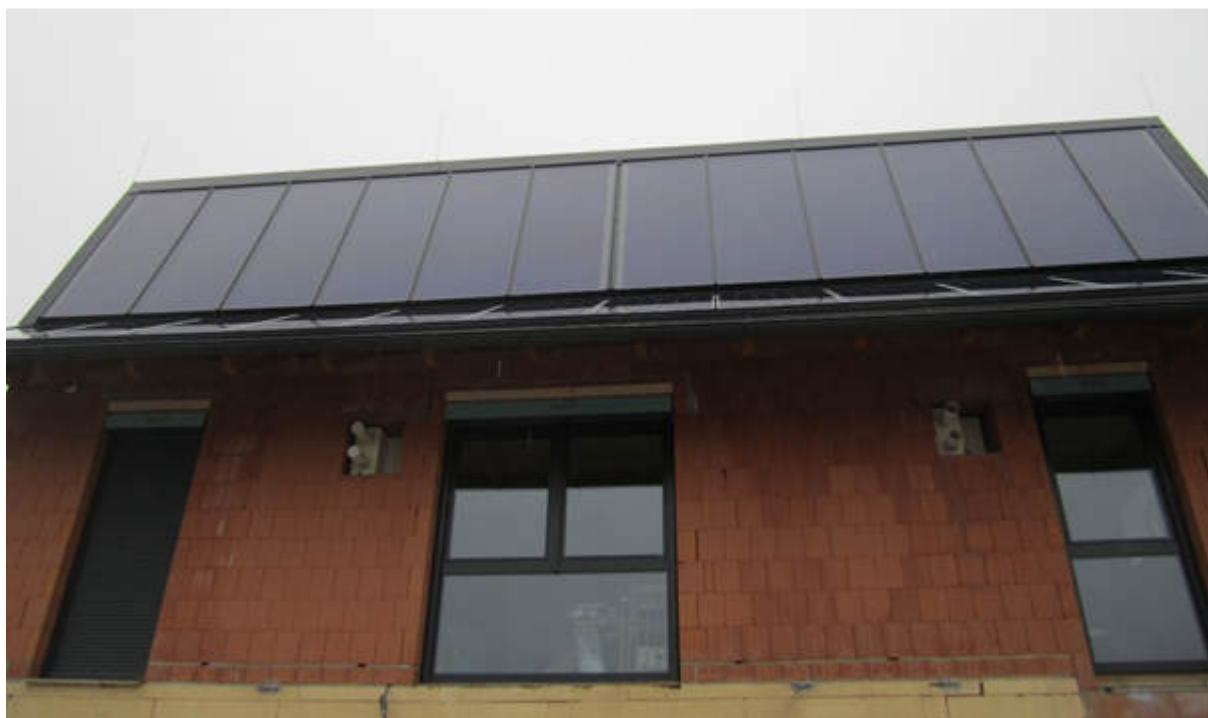
Abbildung 80: Süd-Südwest-Ansicht des Gebäudes mit Solarthermie-Kollektoren (oben) und PV-Modulen (unten), (Quelle: AIT)
