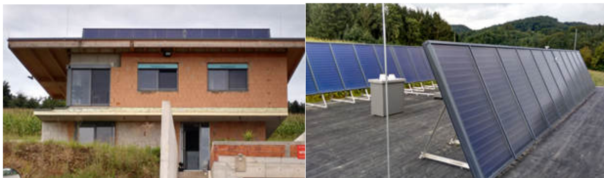
Abbildung 91: Südansicht des Solarhauses Schachinger und Solaranlage am Dach (Quelle: AEE INTEC)
