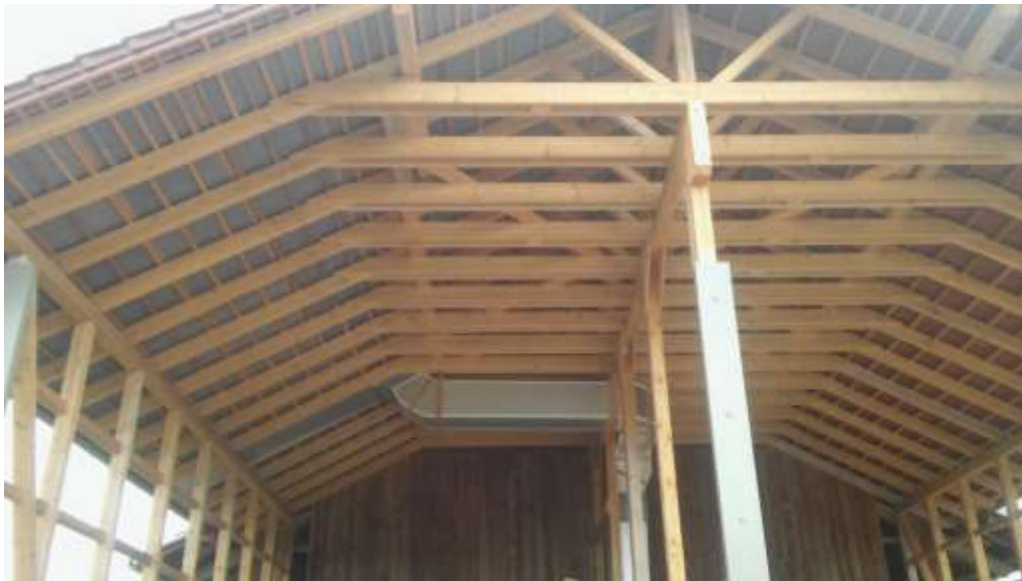
Abbildung 13: Solarleitung vom Dach zu Steinspeicher bzw. Mischkammer der Hackguttrocknung Mader (Quelle: Bauherr)
