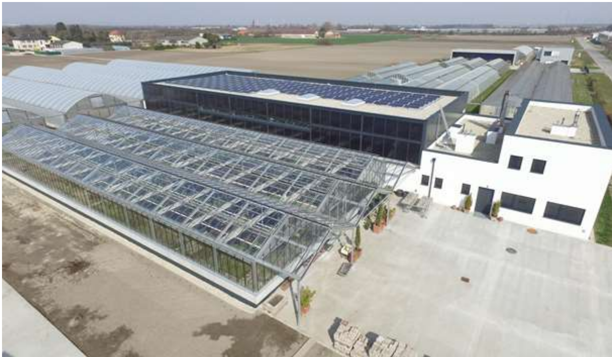
Abbildung 30: Südansicht der Gärtnererei Bach. Im Vordergrund die mit Bauteilaktivierung beheizten Glashäuser. Die Solaranlage ist in die Fassade integriert. Am Dach ist eine PV-Anlage installiert (Quelle: Bauherr)
