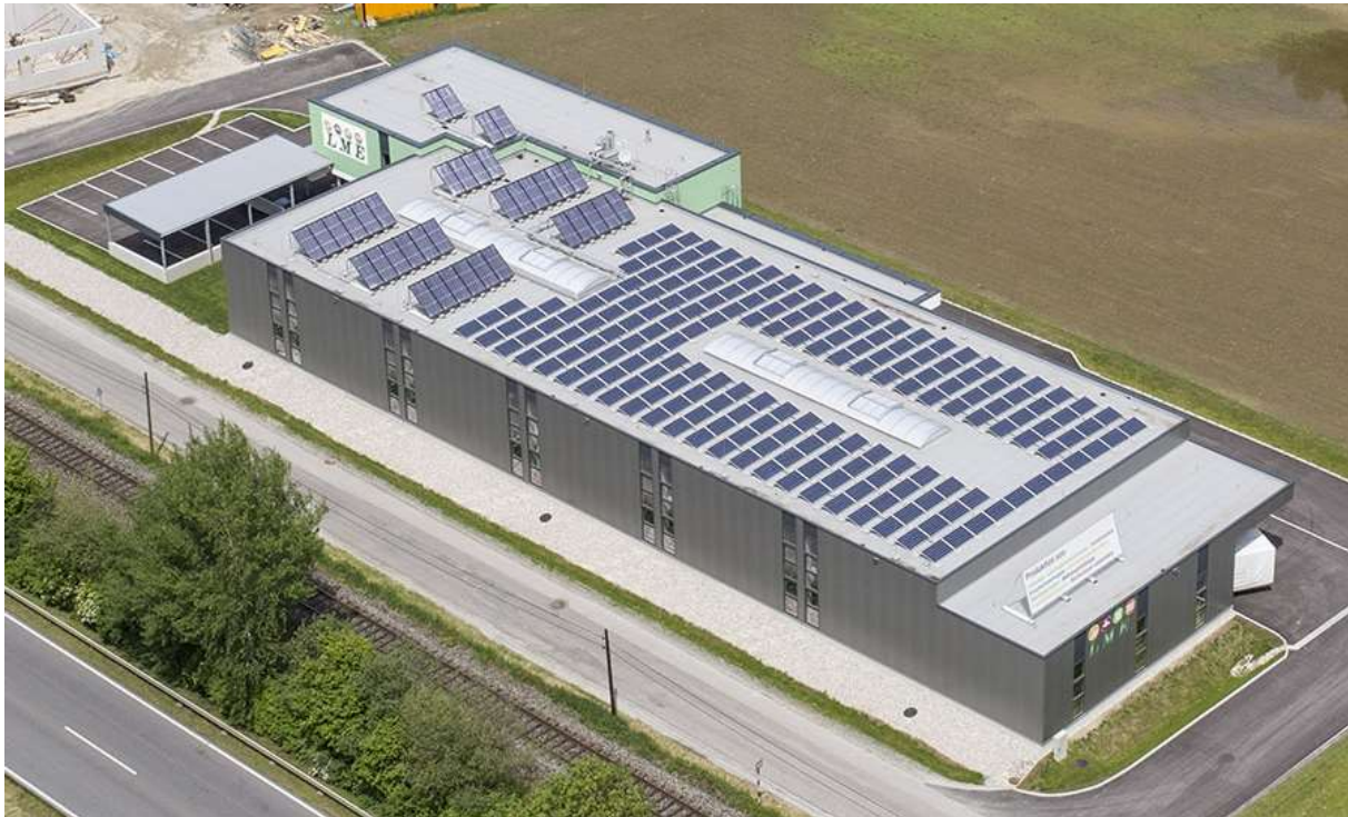
Abbildung 5: LME Produktionshalle mit Solarthermie-Kollektoren (im Bild links) und Photovoltaikmodulen (im Bild rechts). Quelle: LME
