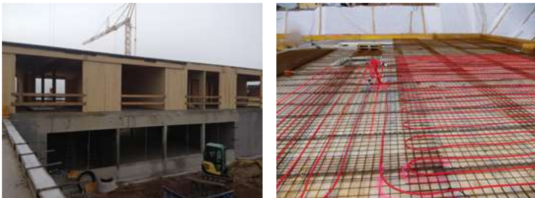
Abbildung 36: Baufortschritt des Neubaus Volksschule Hallwang im Dezember 2016 (links), Verlegung der Bauteilaktivierung (rechts) (Quelle: vollSOLAR)
