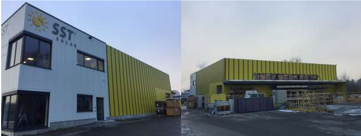
Abbildung 53: Süd-West- (links) und Süd-Ostansicht (rechts) des Neubaus der SST Solar. Die Kollektormontageschienen (schwarze Streifen auf gelbem Grund) sind bereits an der Fassade angebracht (Bildquelle: SST Solar)
