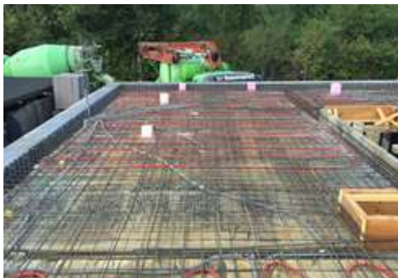
Abbildung 32: Fertig verlegte Bauteilaktivierung Decke Erdgeschoß (links); Südansicht des Solarhauses Förster (rechts) (Quelle: Bauherr)
