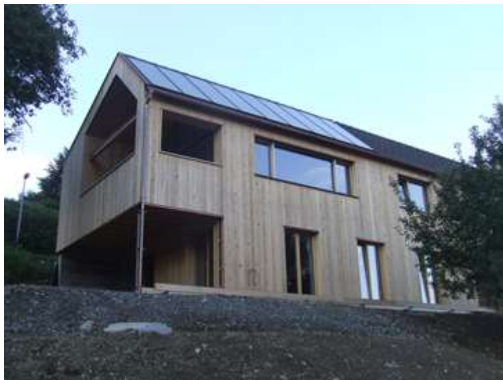
Abbildung 5: Südansicht des Solarhauses Bader (Quelle: AEE INTEC)
