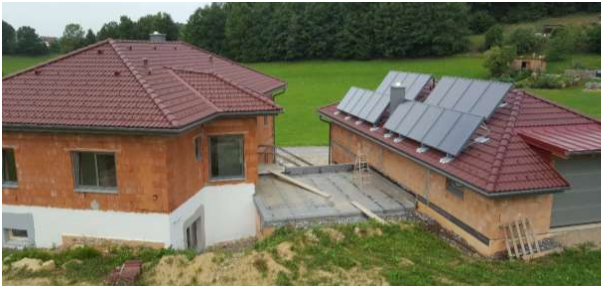
Abbildung 55: Außenansicht Rohbau Wurzer-Rapolter (Quelle: AIT)
