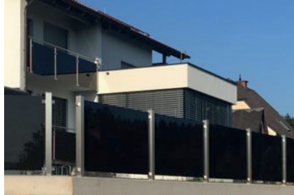
Neue Anwendungsmöglichkeit Photovoltaik-Zaun
