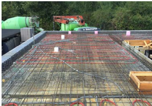
Abbildung 20: Fertig verlegte Bauteilaktivierung Decke Erdgeschoß (links); Südansicht des Solarhauses Förster (rechts) (Quelle: Bauherr)
