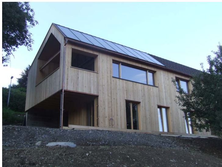
Abbildung 5: Südansicht des Solarhauses Bader (Quelle: AEE INTEC)
