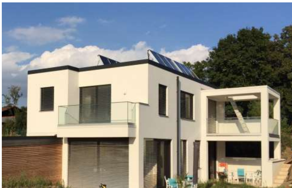
Abbildung 5: Westansicht des Solarhauses Fasching (Quelle: Bauherr)
