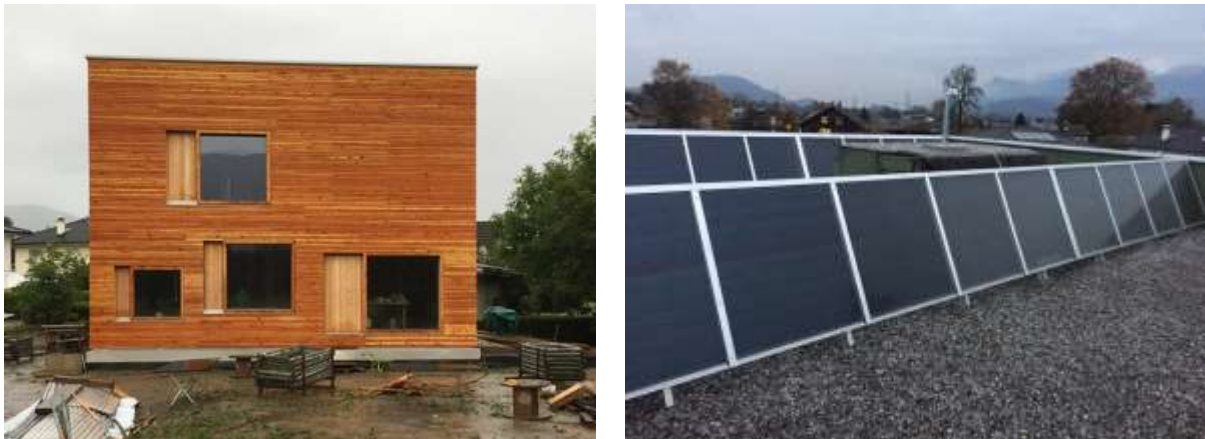
Abbildung 16: Südansicht des Solarhauses Krug (links), Solaranlage am Dach (rechts) (Quelle: Bauherr)
