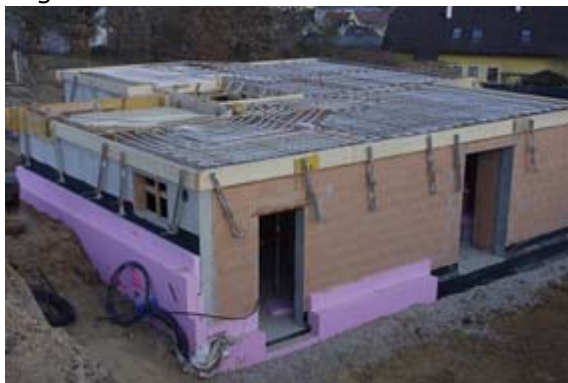
Abbildung 20: Fertig verlegte Bauteilaktivierung Decke Erdgeschoß (links); Südansicht des nahezu fertigen Gebäudes (rechts) (Quelle: Bauherr)
